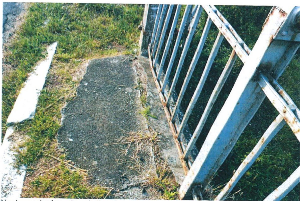
Nové mostní vybavení – pokud možno se zachováním původního nýťovaného zábradlí
