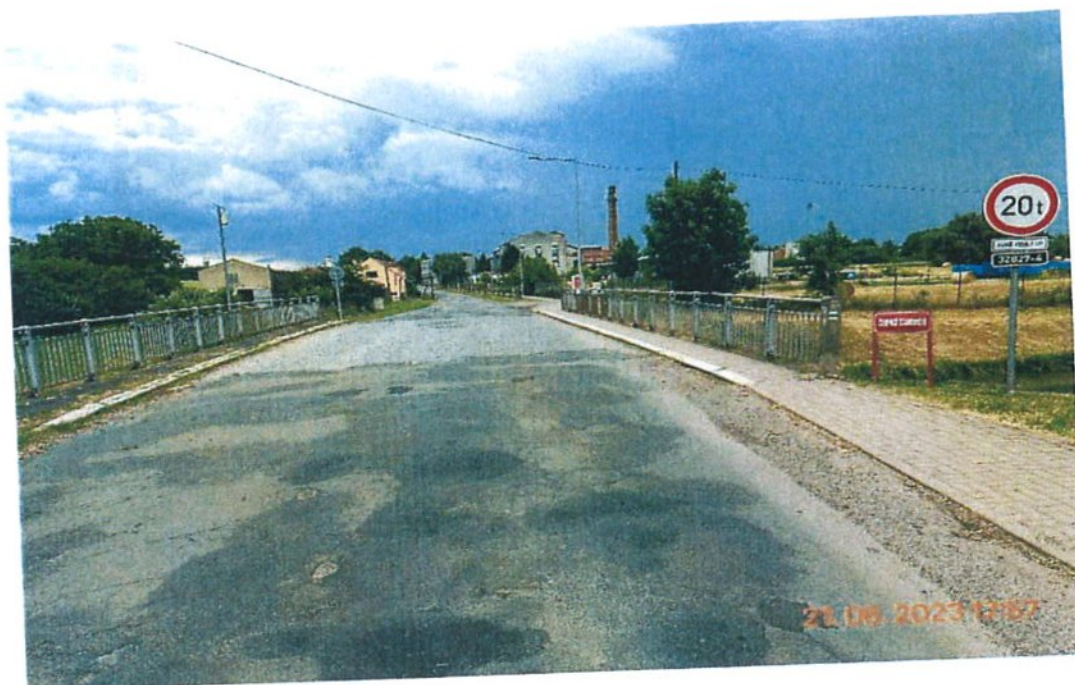
Vozovka a mostní vybavení
