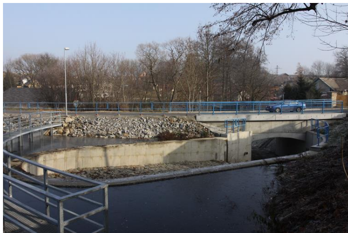
Obr. 2: Bezpečnostní přeliv – průchodnost pro vydru: Neprůchodný BP (vlevo) – svislá přelivná hrana výšky 1 m je nepřekonatelná pro vydru i pro většinu dalších živočichů. Zde je bariérový účinek navíc zvýšen předsazenou ocelovou lávkou s česlemi. Zvířata migrující podél vodního toku jsou nucená přebíhat přes frekventovanou silnici; vpravo - neprůchodný BP z pohledu vydry migrující proti proudu vodního toku. Vydra je v tomto případě schopná projít most pod silnicí, narazí ale na svislou zeď bezpečnostního přelivu, jehož bariérový účinek je navíc zvýšen kovovými česlemi. Zvíře nemá jinou možnost než se vrátit a pokusit se přeběhnout vrchem hráze rybníka s frekventovanou silnicí.
