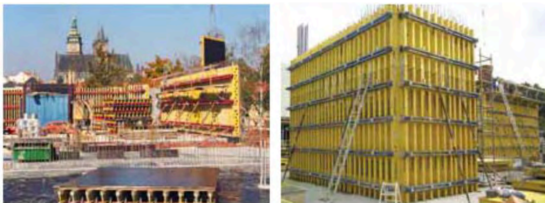
(25) Obr. F.4 – Nosníkové bednění
