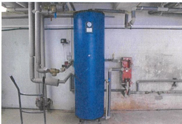
Obrázek 13 - Příprava TV v budově A
