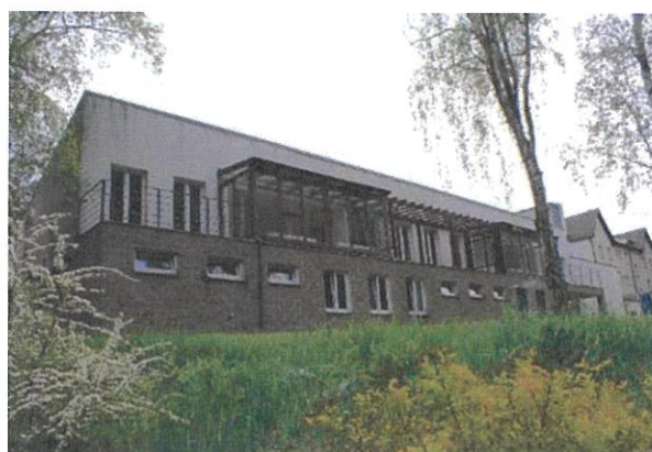
Obrázek 5 – Pohled II – Technický monoblok
