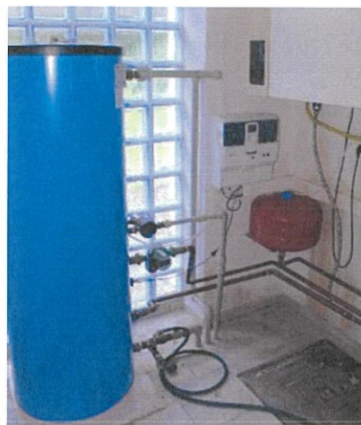
Obrázek 14 - Příprava TV v budově B
