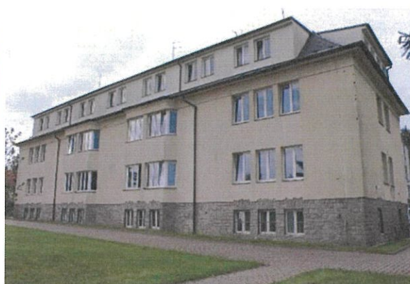
Obrázek 3 - Pohled II – hlavní budova
