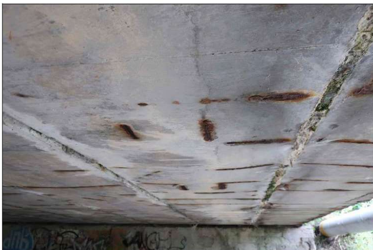
podélná trhlina s výluhy pojiva na spodním líci 2. nosníku kopírující trajektorii předpínací výztuže koroze obnažené konstrukční výztuže
