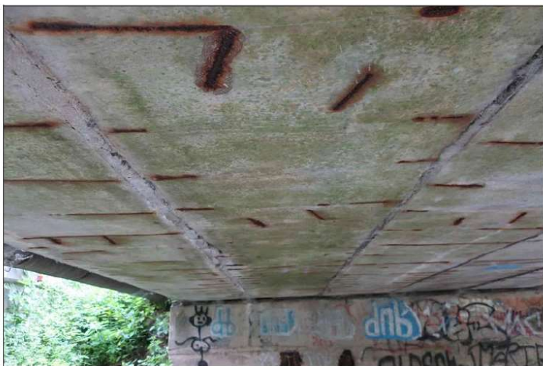
podhled 8. nosníku
