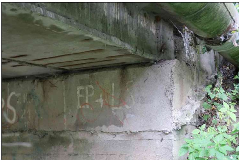
uložení 9. nosníku na opěru 2
