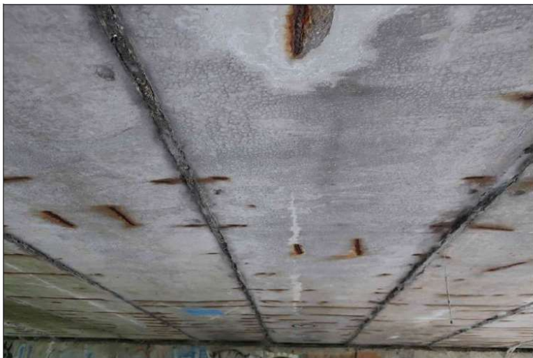
podélná trhlina s výluhy pojiva na spodním líci 5. nosníku kopírující trajektorii předpínací výztuže intenzivní koroze obnažené konstrukční výztuže
