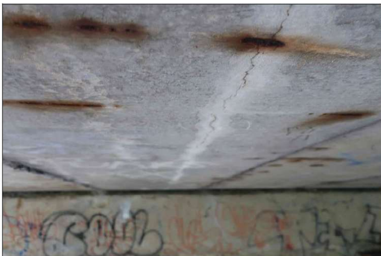
podélná trhlina s výluhy pojiva na spodním líci 4. nosníku kopírující trajektorii předpínací výztuže intenzivní koroze obnažené konstrukční výztuže
