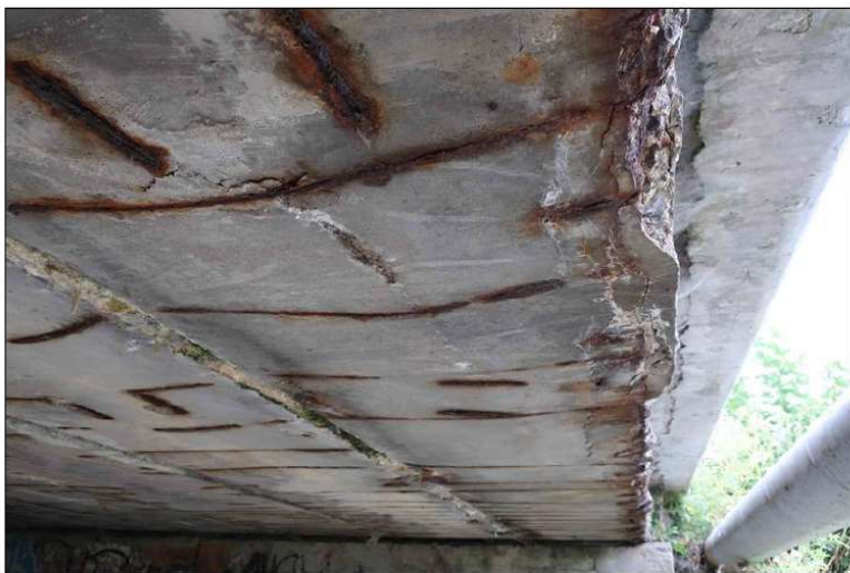
podélná trhlina s výluhy pojiva na spodním líci 1. nosníku kopírující trajektorii předpínací výztuže intenzivní koroze obnažené konstrukční výztuže
