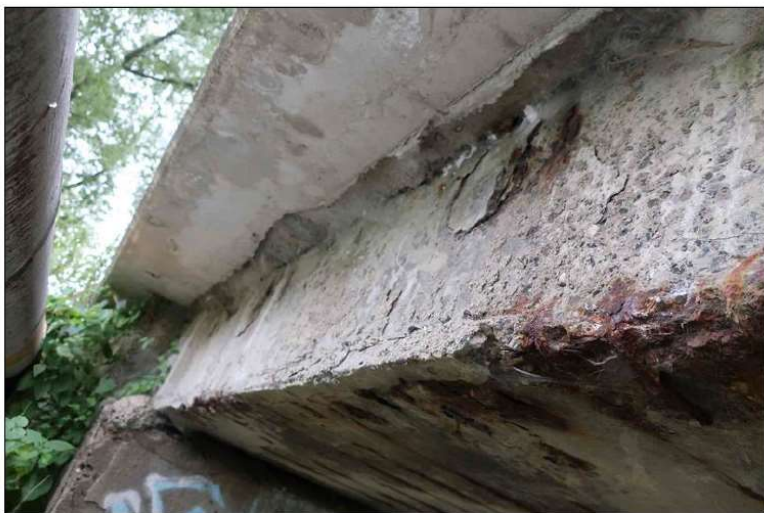
degradace betonu a koroze betonářské výztuže 1. nosníku na vnějším boku
