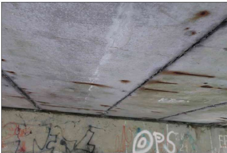
podélná trhlina s výluhy pojiva na spodním líci 7. nosníku kopírující trajektorii předpínací výztuže intenzivní koroze obnažené konstrukční výztuže
