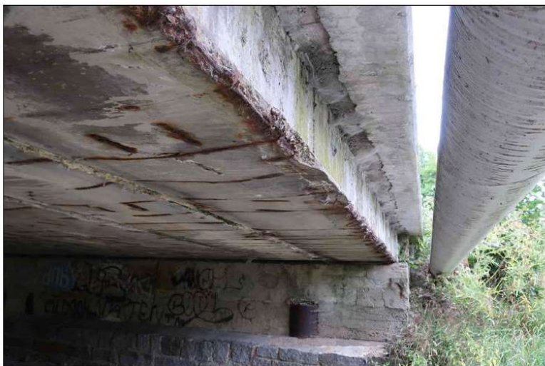
celkový pohled na 1. nosník
