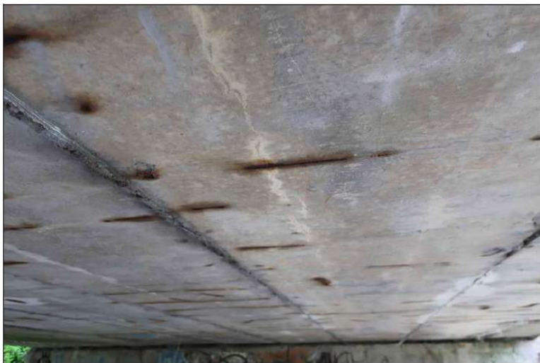
podélná trhlina s výluhy pojiva na spodním líci 3. nosníku kopírující trajektorii předpínací výztuže intenzivní koroze obnažené konstrukční výztuže
