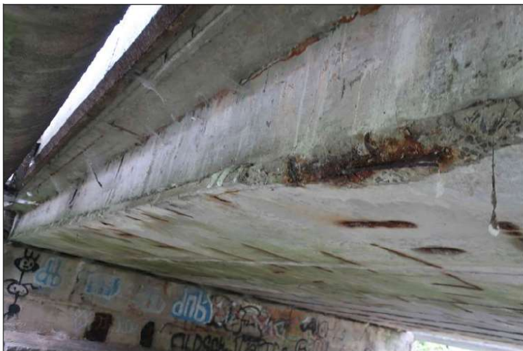
pohled na 9. nosník
