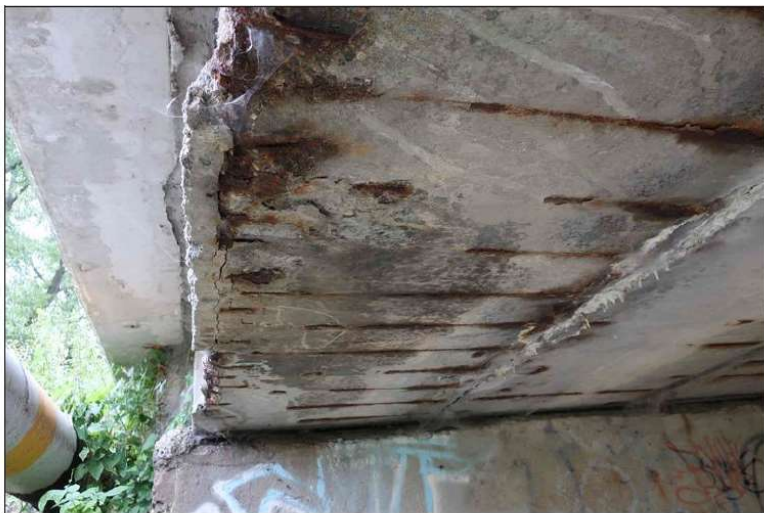
podhled 1. nosníku před opěrou 2
