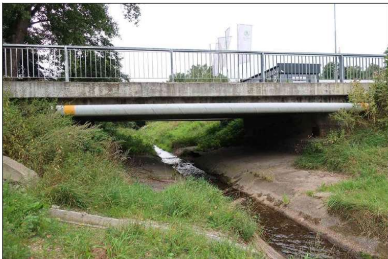
pohled na most
