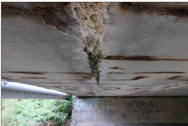
stopy po průsaku sparou mezi 1. a 2. nosníkem
