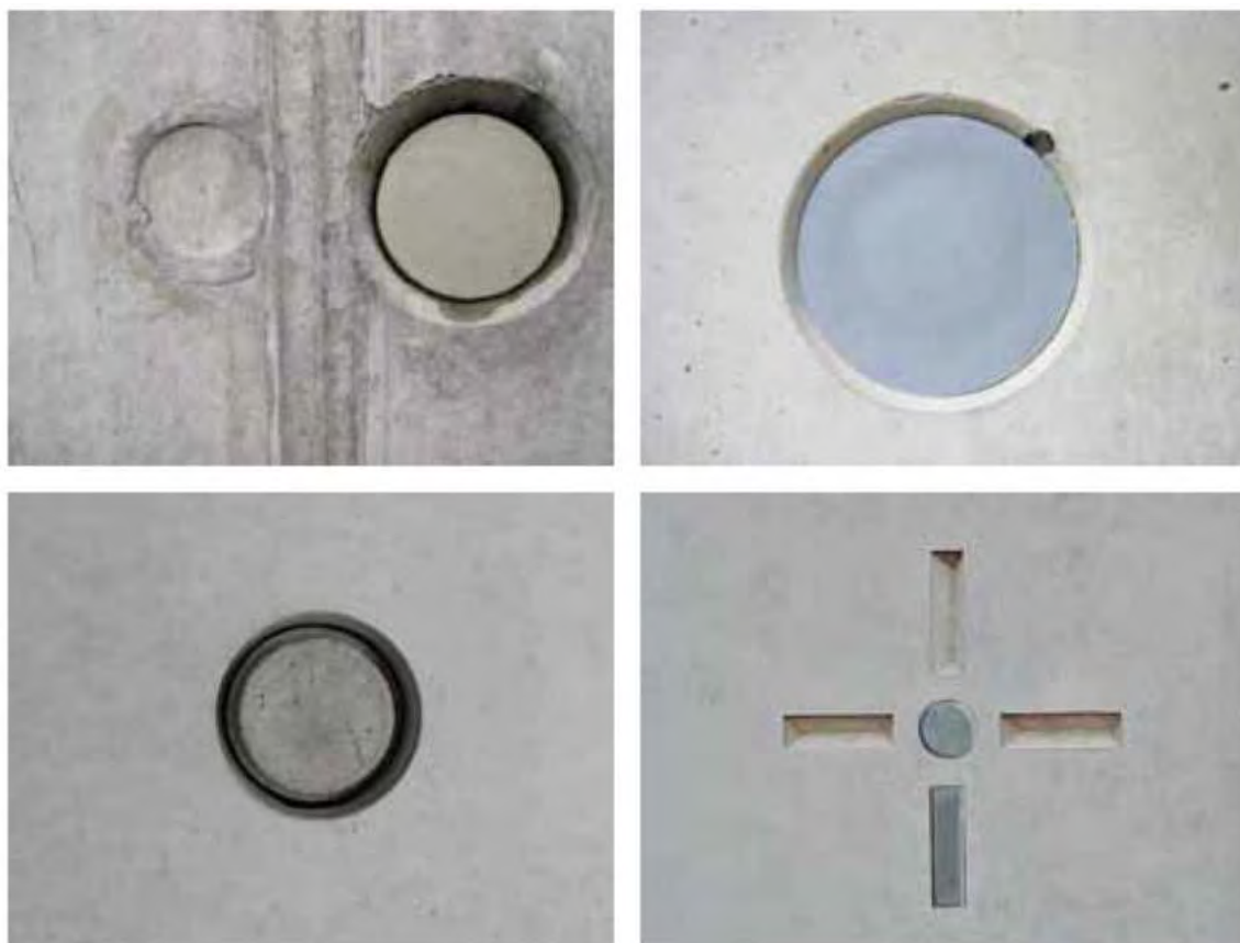
(23) Obr. F.2 – Různé způsoby uzavření spínacích otvorů
