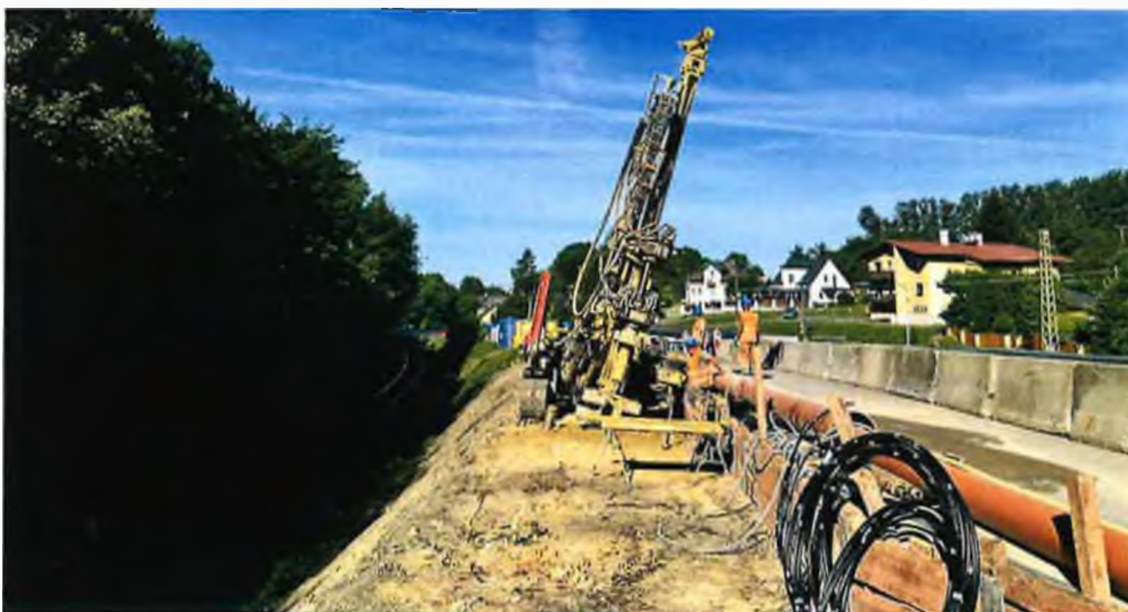
Obr. 1 Snímek vrtné soupravy u hrany sanovaného svahu při realizaci mikropiloty.
