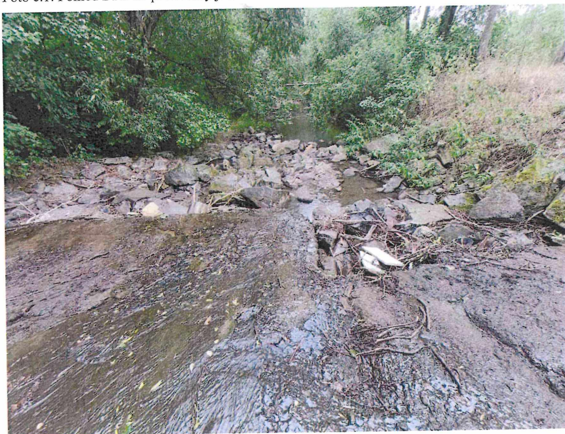
Foto č.2: Pohled směrem po proudu na podplavenou skluzovou část tělesa jezu a rozplavený zához
