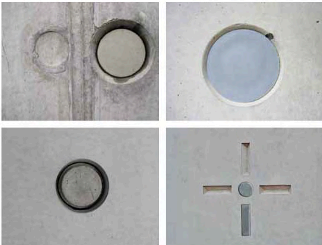
(23) Obr. F.2 – Různé způsoby uzavření spínacích otvorů
