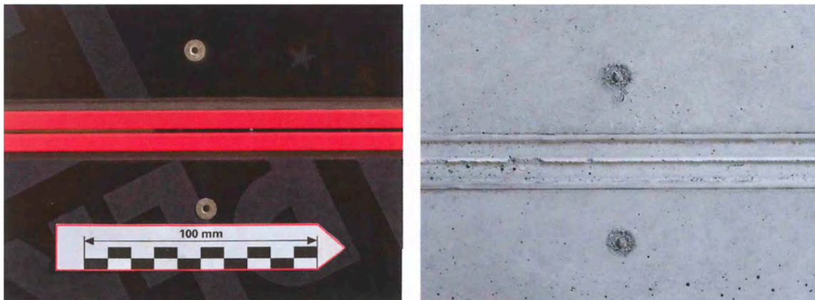
a) z pohledové strany u rámového bednění (vlevo bednění / vpravo povrch betonu)
