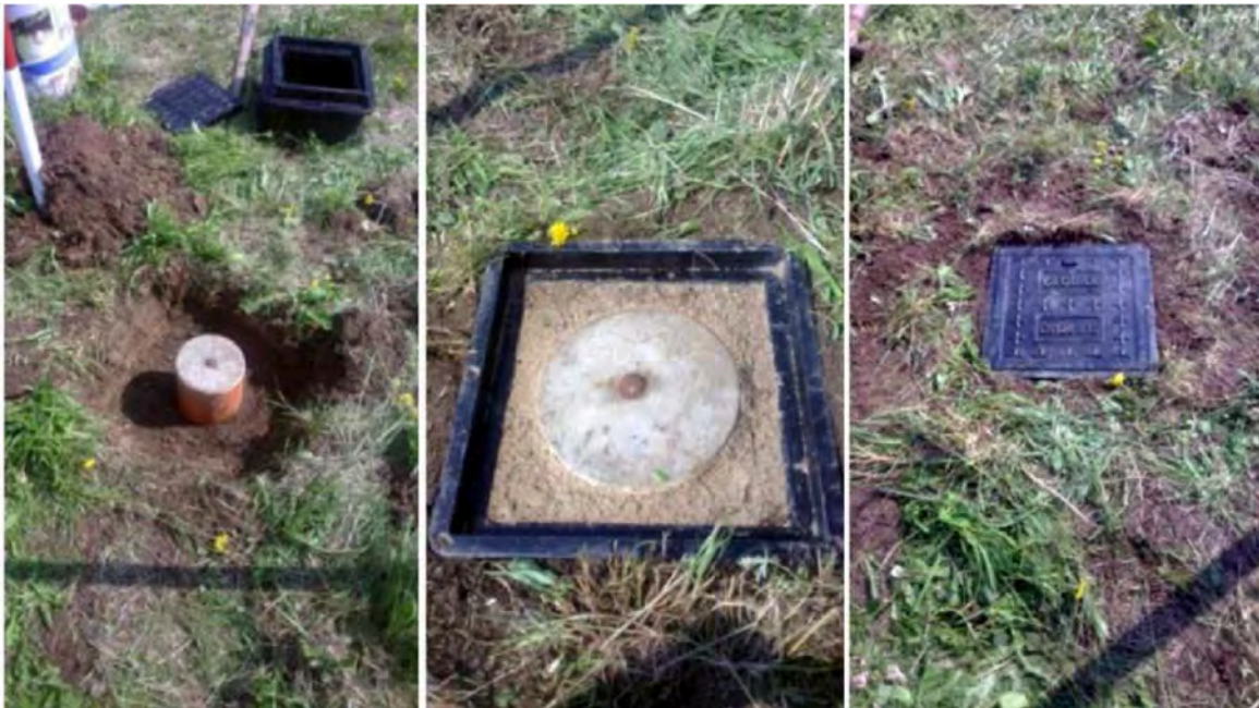
Obrázek 41 Příklad řešení plastové šachty hranaté
