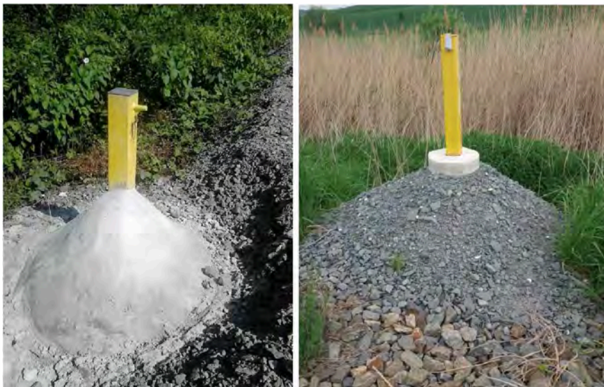
Obrázek 17 Řešení zhotovitele pro zvýšení stability zajišťovací značky
