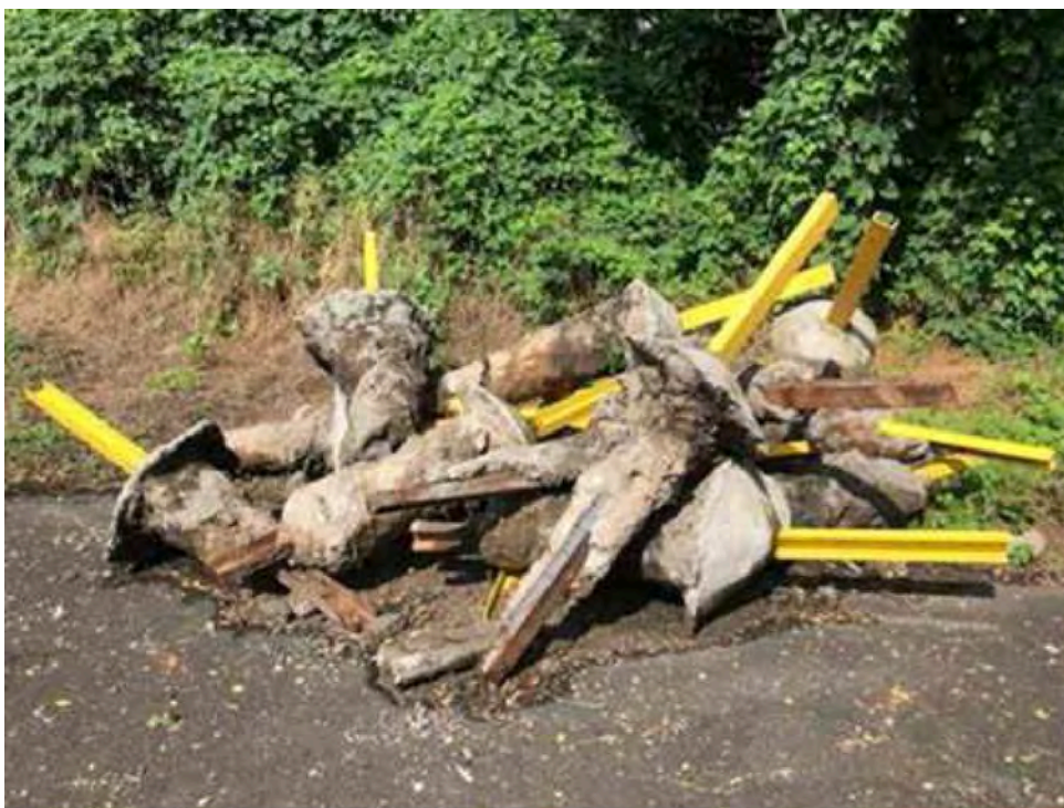
Obrázek 22 Odstraněné zajišťovací značky z opravné práce při rekonstrukci koleje
