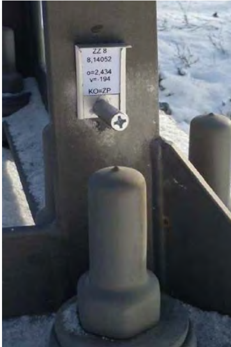
Obrázek 9 Konzolová značka na podpěře trakčního vedení
