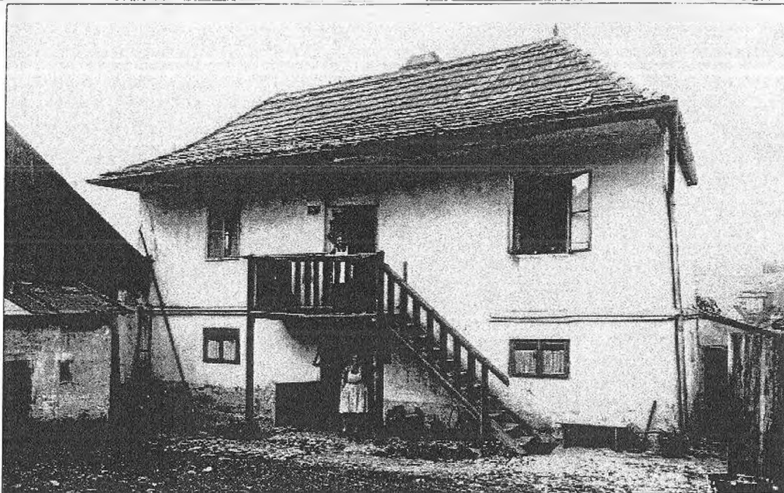
Obrázek: Původní obytná budova Na Truhlářce (1928)
