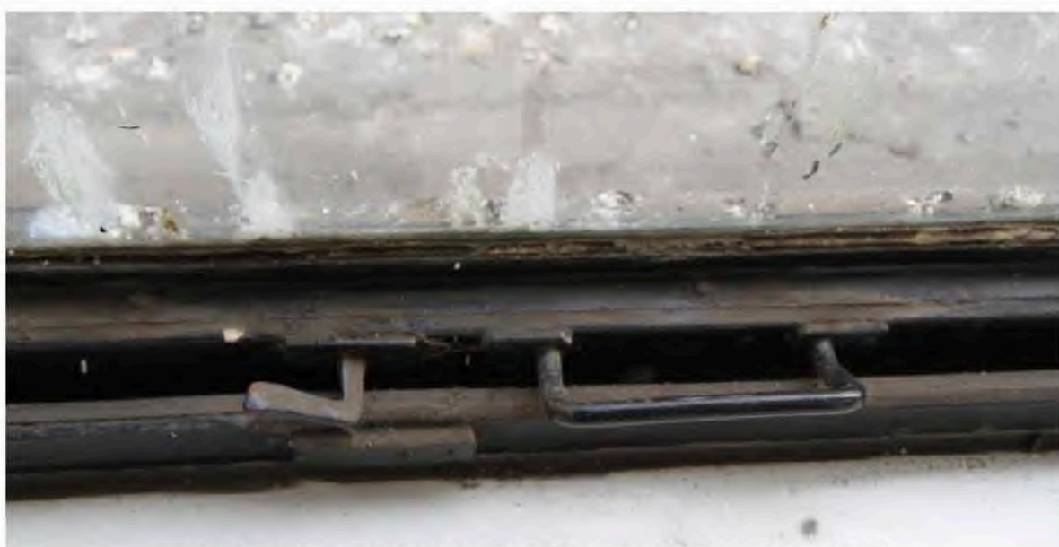
Obrázek 19: Detail druhotného obrtlíku na výkladeci v místnosti M5
