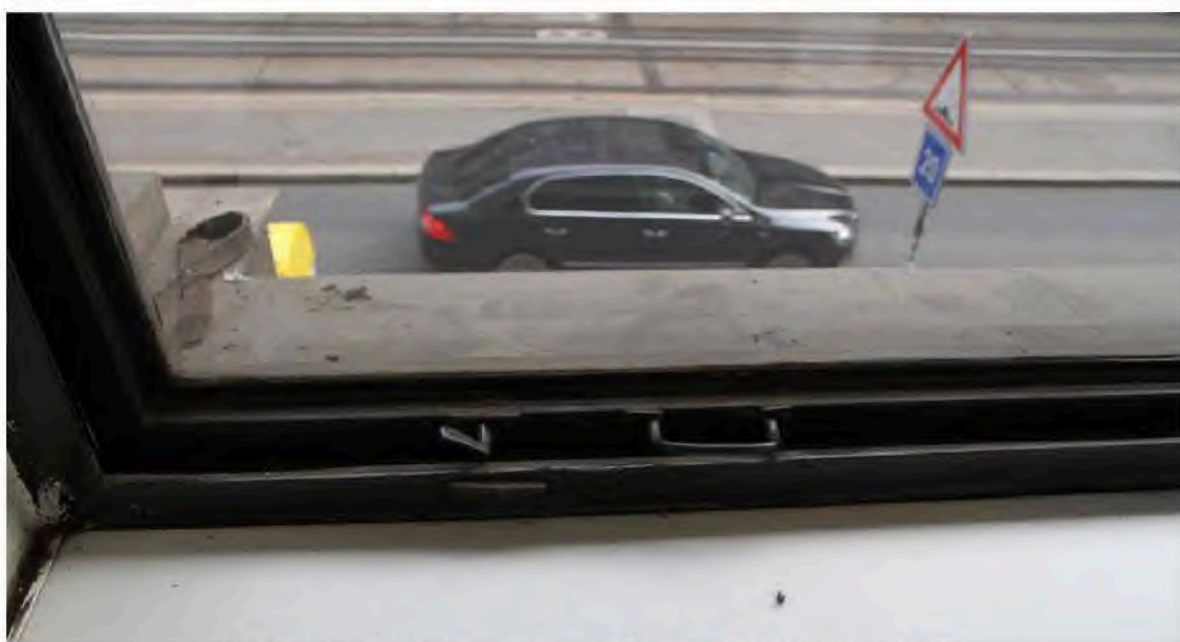
Obrázek 24: Výkladec v místnosti M2 - detail druhotného obrtlíku
