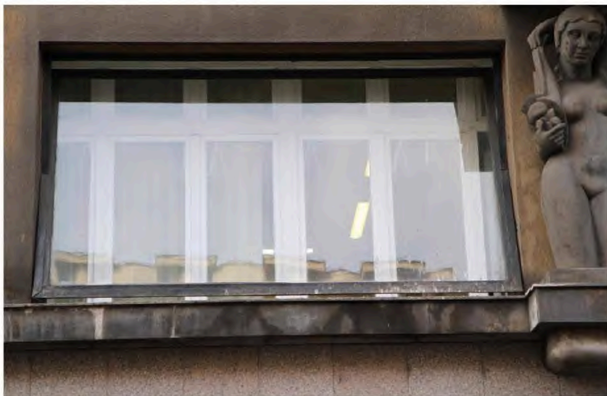
Obrázek 16: Pohled na výkladec v místnosti M5 z exteriéru
