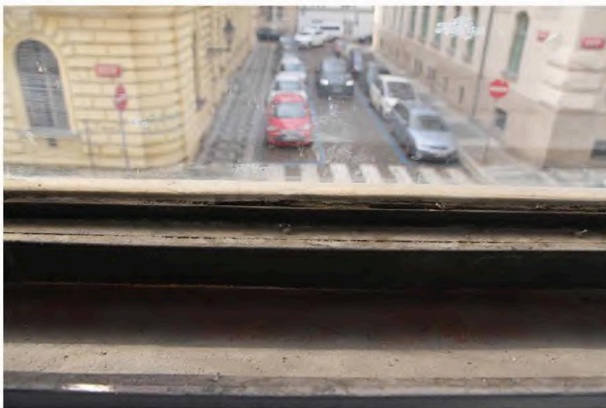
Obrázek 60: Výkladec v místnosti M10 - detail vyžilého těsnění
