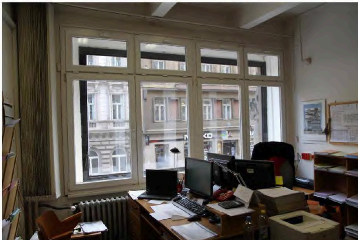
Obrázek 26: Výkladek v místnosti M1 – pohled z interiéru
