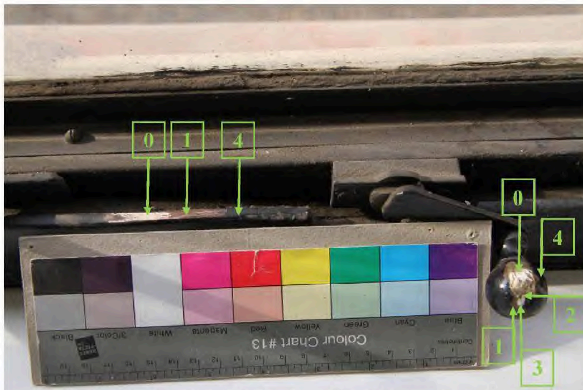
Obrázek 44: Sonda provedená na rámu a klíče výkladce v místnosti M7
