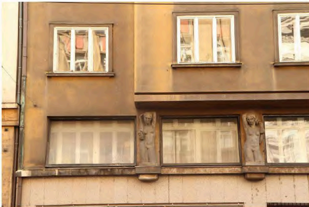
Obrázek 4: Detail výkladců na hlavním průčelí vlevo
