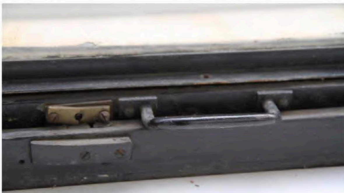
Obrázek 27: Výkladec v místnosti M1 - detail druhotně doplněného obrtlíku
