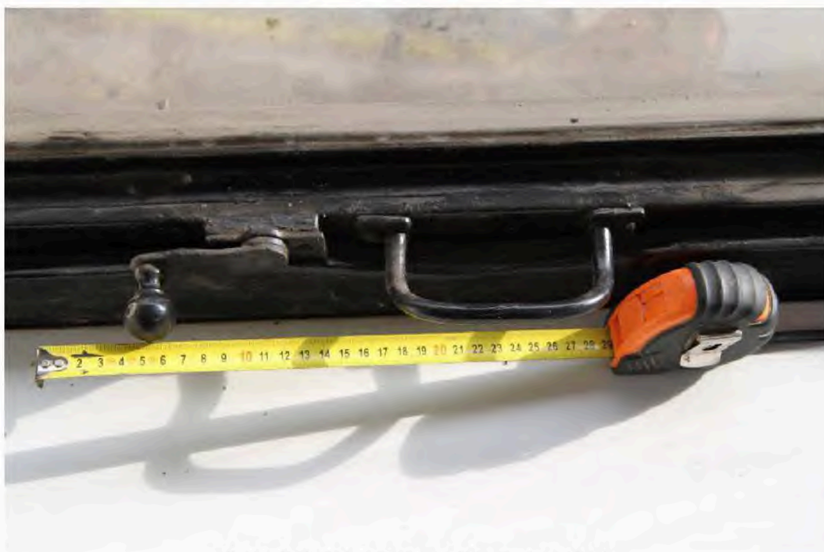
Obrázek 10: Detail původní klíčky v místnosti M3
