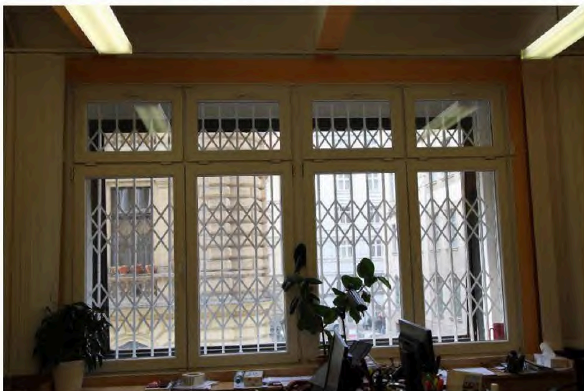
Obrázek 52: Výkladec v místnosti M9 - pohled z interiéru
