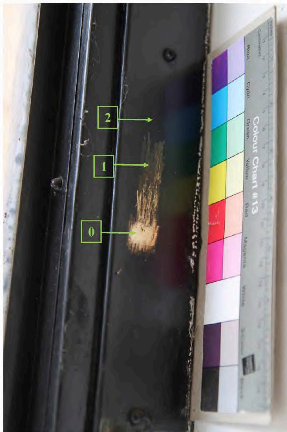
Obrázek 37: Sonda provedená na křídle okna v místnosti M6
