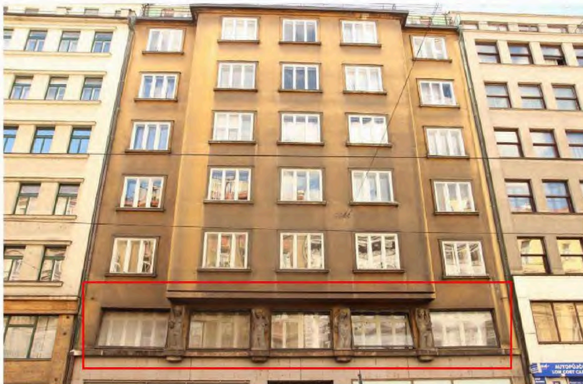
Obrázek 2: Hlavní průčelí s výkladci v úrovni mezaninu
