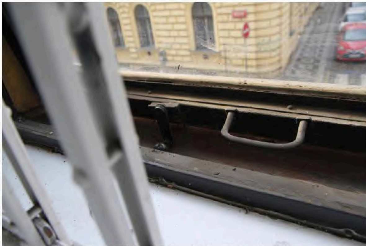
Obrázek 59: Výkladec v místnosti M10 – detail madla a klíčky
