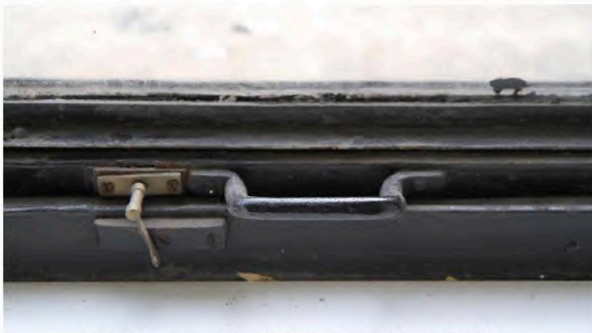
Obrázek 27: Výkladec v místnosti M1 - detail druhotně doplněného obrtlíku
