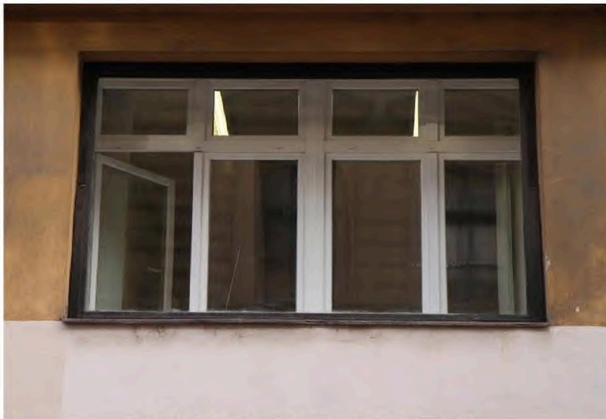
Obrázek 39: Pohled na výkladec v místnosti M7 z exteriéru
