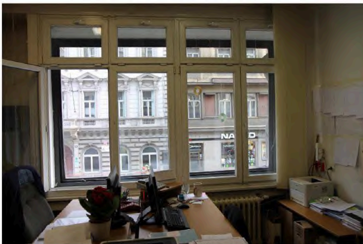
Obrázek 22: Výkladec v místnosti M2 – pohled z interiéru
