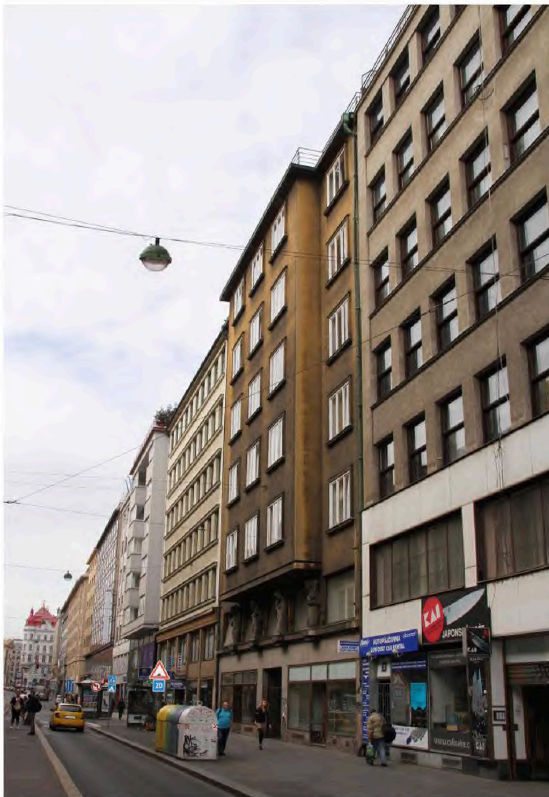
Obrázek 2: Celkový pohled na hlavní průčelí
