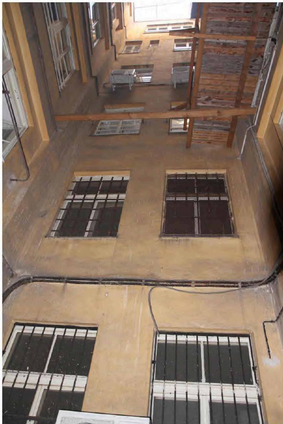
Obrázek 38: Pohled na stěnu světlíku č. 2
