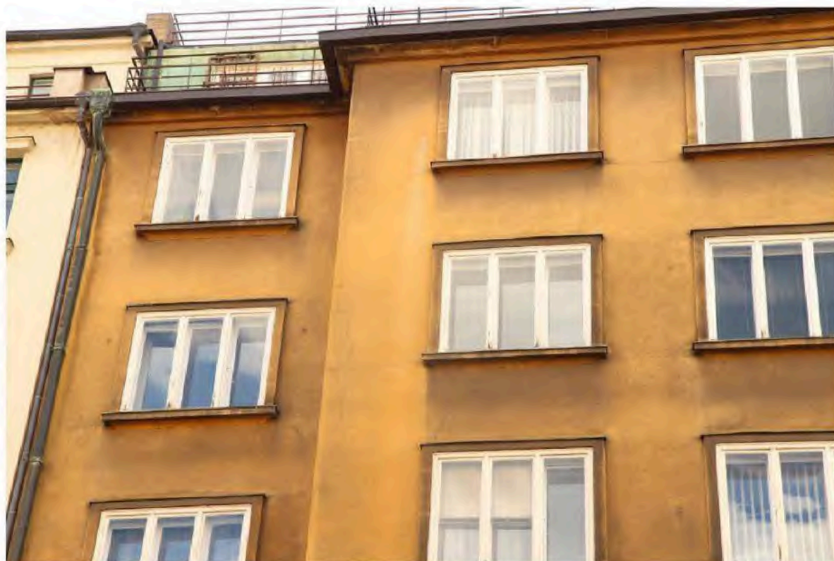
Obrázek 4: Hlavní průčelí - detail
