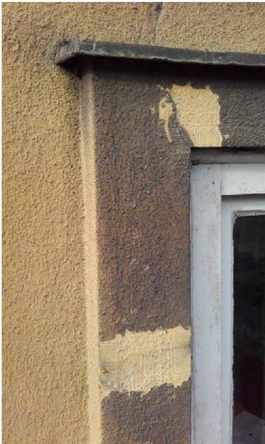
Obrázek 16: Detail světle okrového a tmavého strukturálního nátěru na omítce
