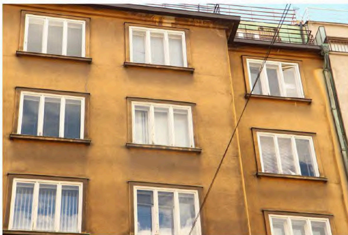
Obrázek 6: Hlavní průčelí – detail
