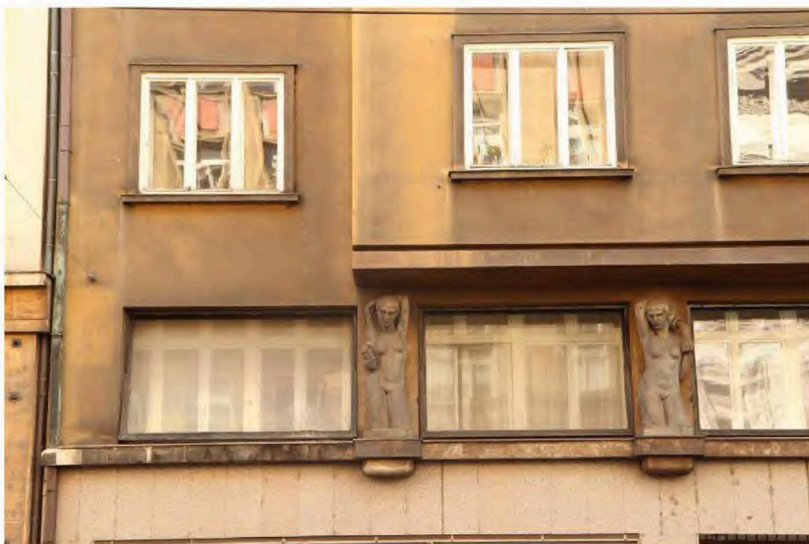
Obrázek 10: Hlavní průčelí – detail
