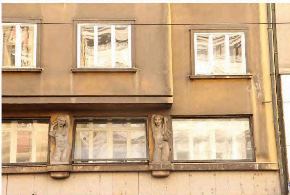
Obrázek 12: Hlavní průčelí – detail
