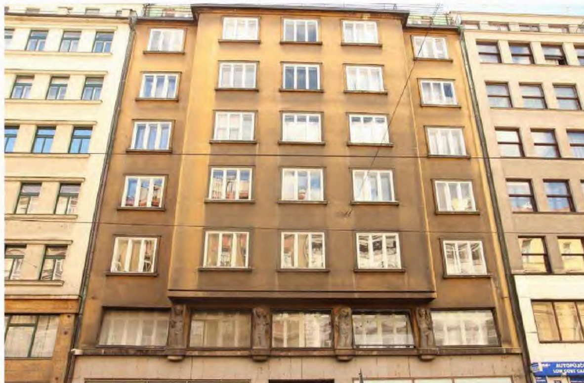
Obrázek 3: Čelní pohled na hlavní průčelí od kordonové římsy výš
