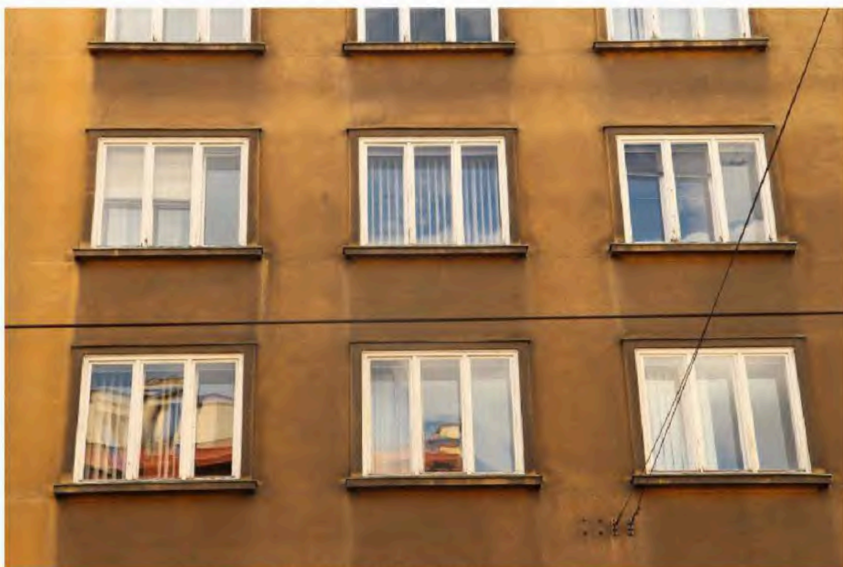
Obrázek 8: Hlavní průčelí – detail
