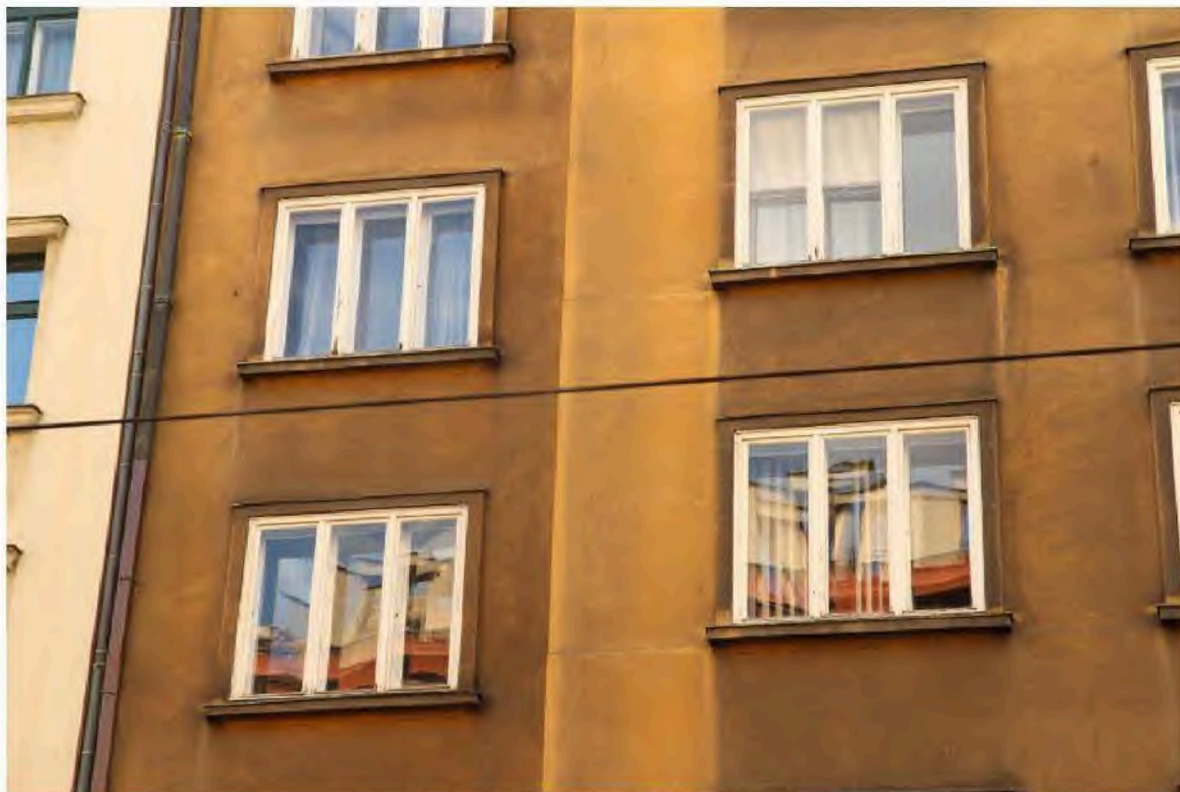
Obrázek 7: Hlavní průčelí – detail
