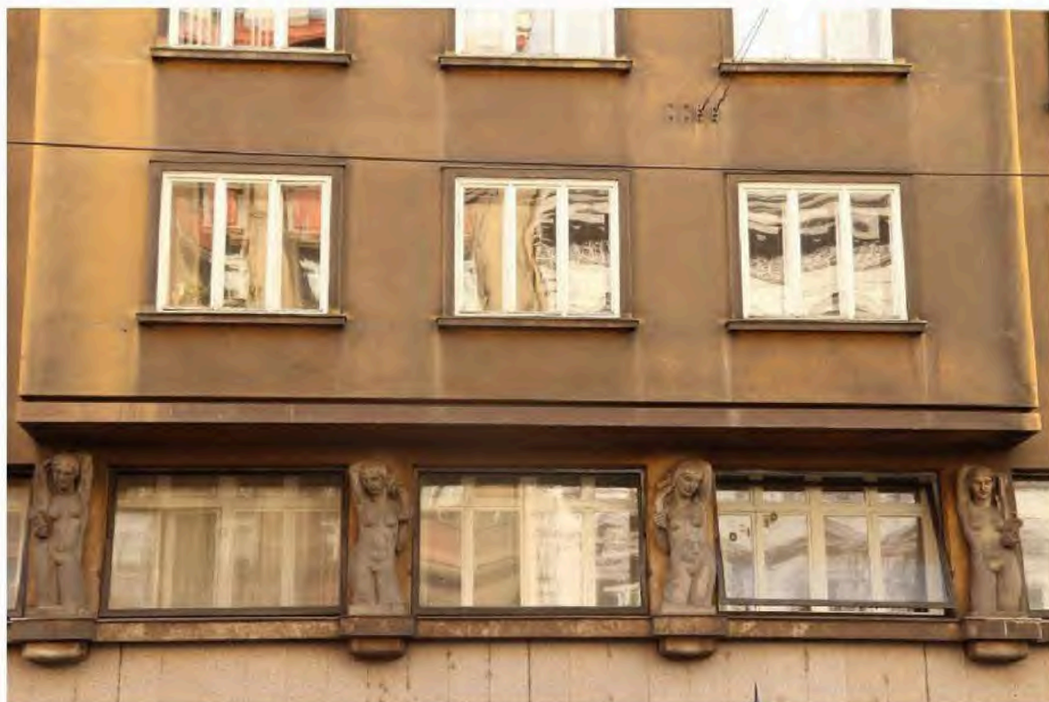
Obrázek 11: Hlavní průčelí – detail
