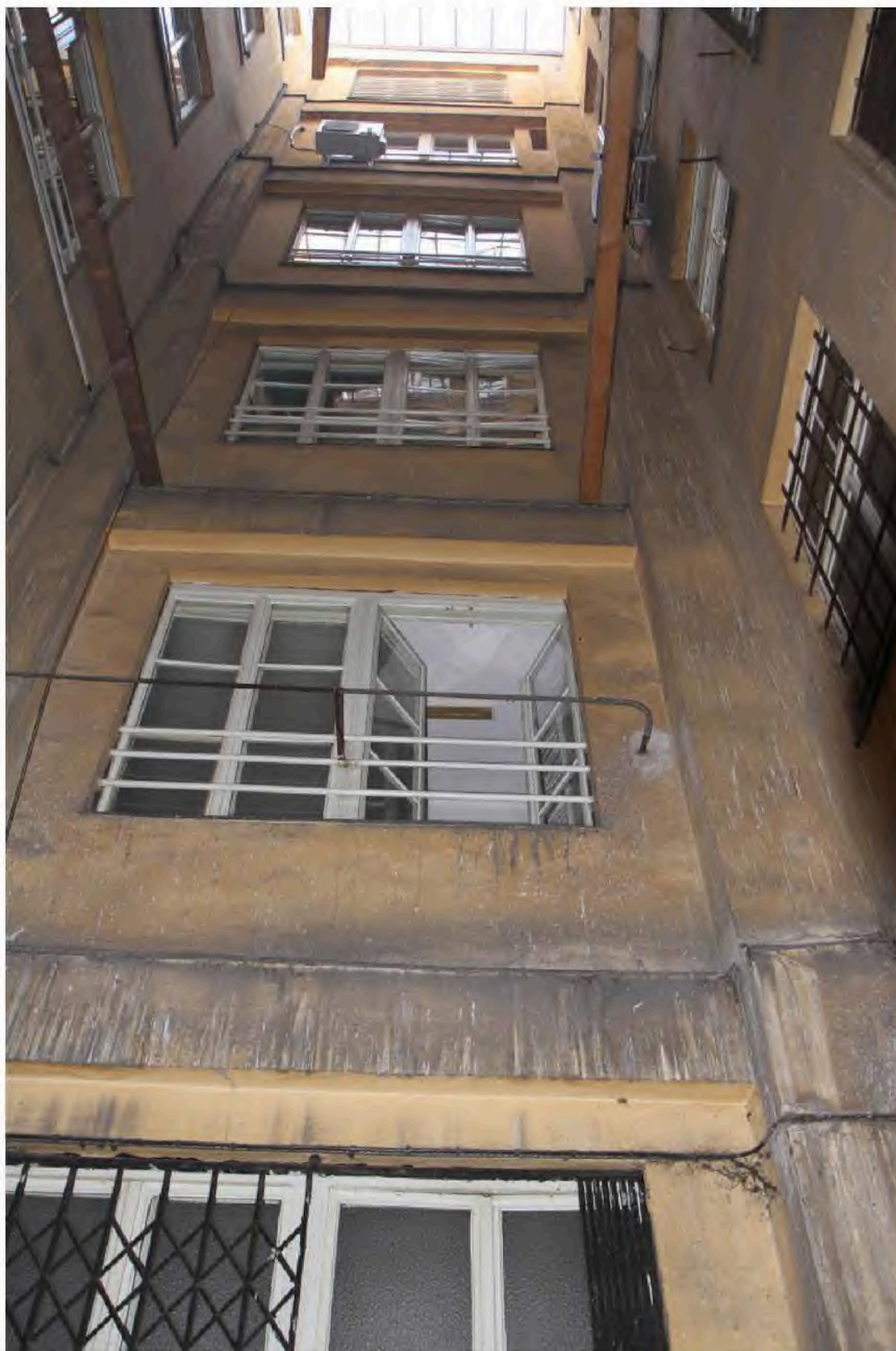
Obrázek 37: Pohled na stěnu světlíku č. 2
