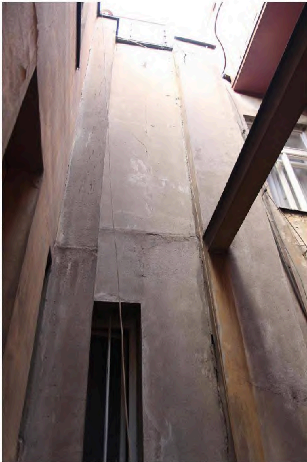
Obrázek 51: pohled na stěnu světlíku č. 3
