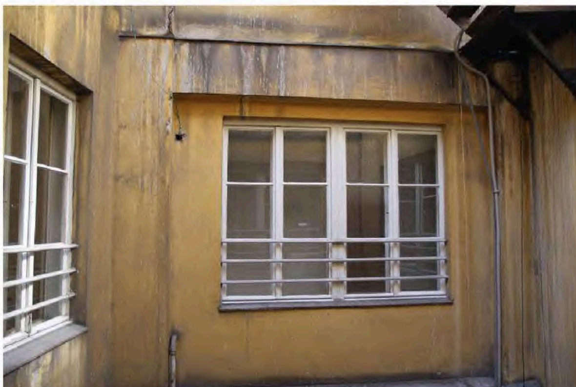
Obrázek 48: Detail stavu omítek světlíku č. 2
