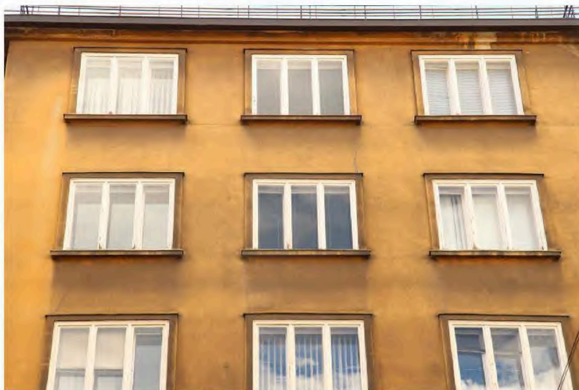
Obrázek 5: Hlavní průčelí – detail
