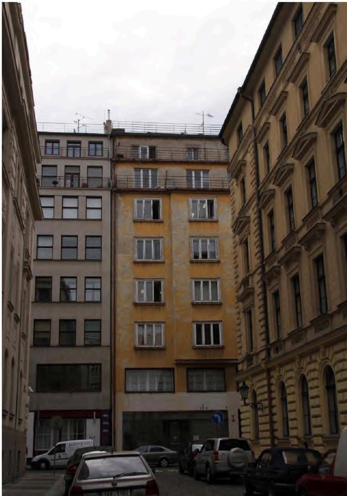
Obrázek 20: Pohled z ulice K Haštalu
