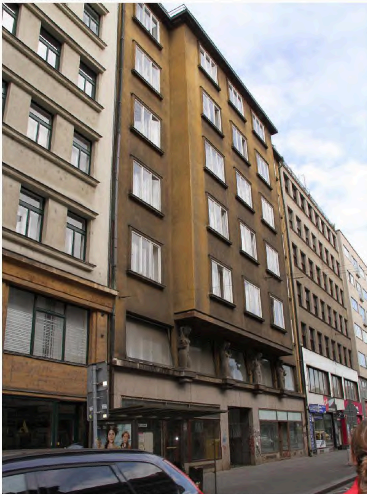
Obrázek 1: celkový pohled na hlavní průčelí
