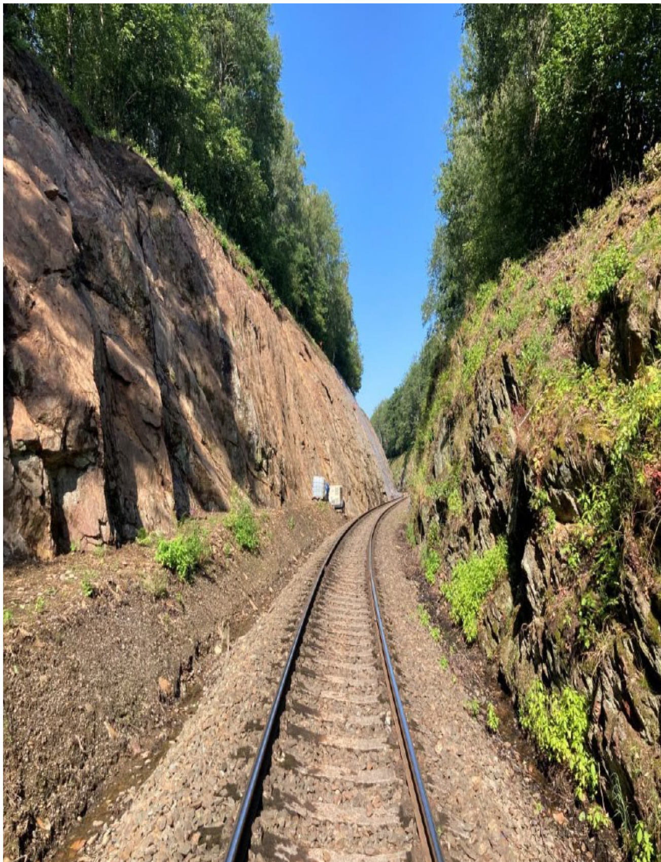
Pohled na vyčištěnou spodní lavici v km 27,850
