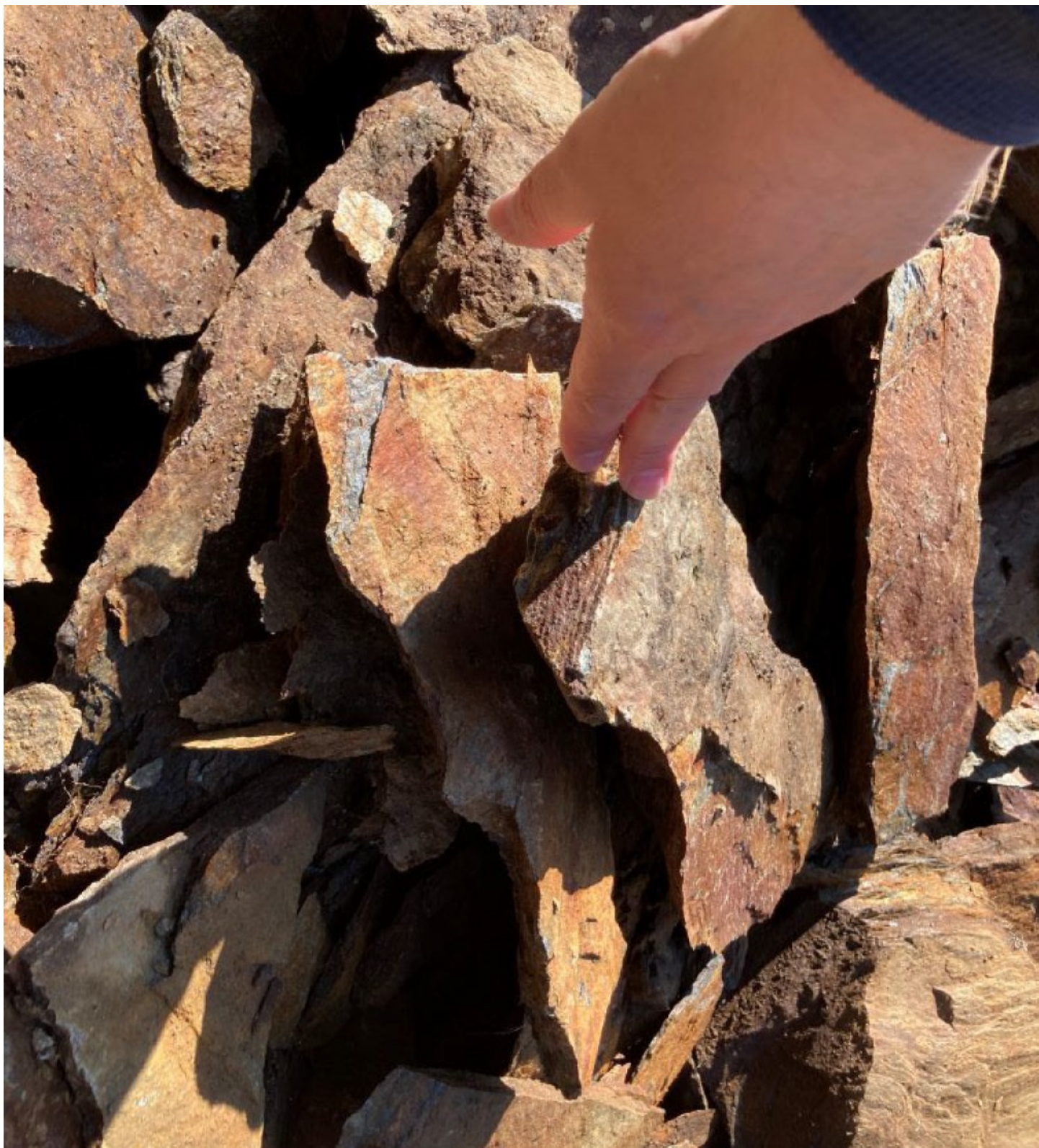
Charakter úlomků po provedení očisty, km 27,700
