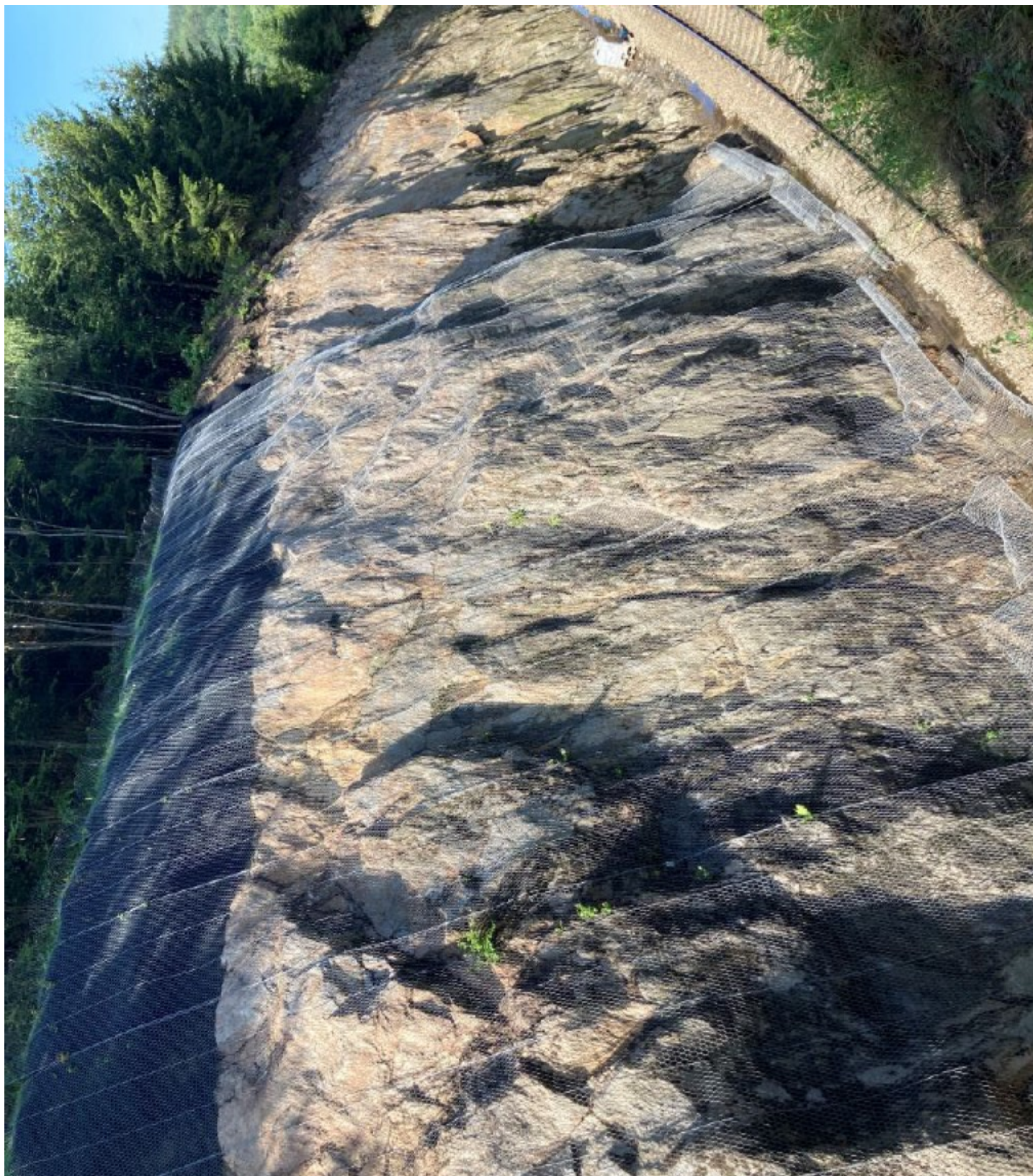
Pohled na začátek zářezu, počátek síťování v km 27,650 - 27,720
