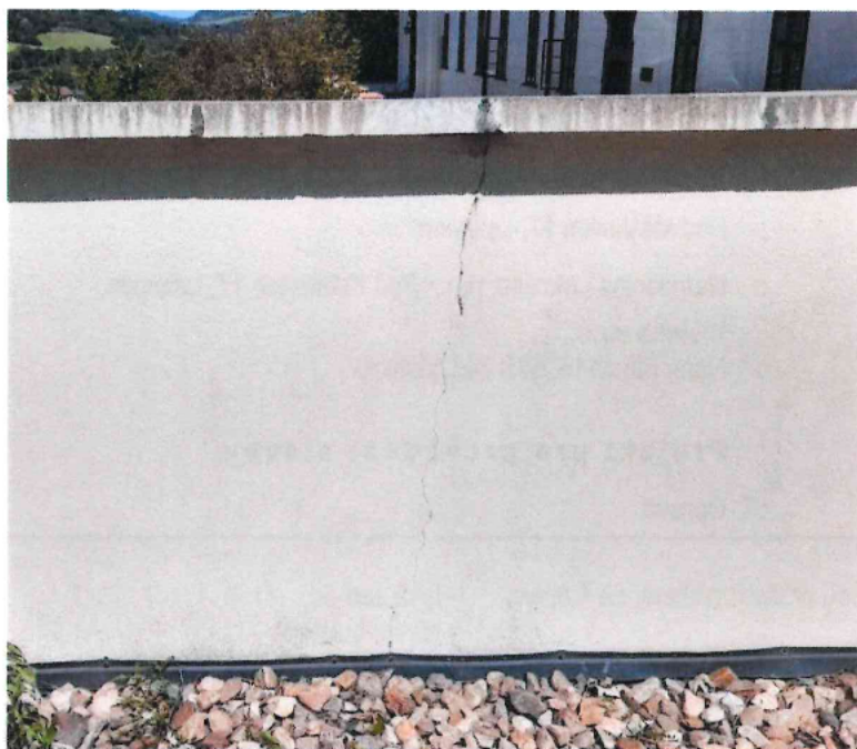
Prasklina v omítce – pravděpodobně dilatační, dožilá ukončovací lišta nopové fólie
