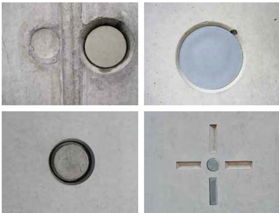
(23) Obr. F.2 – Různé způsoby uzavření spínacích otvorů
