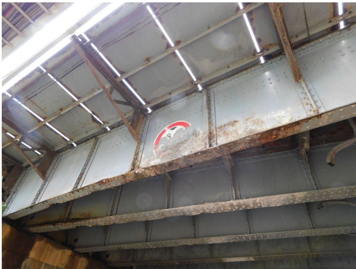
foto_K_01_hlavni_nosnik_01_deformace_II_2023
