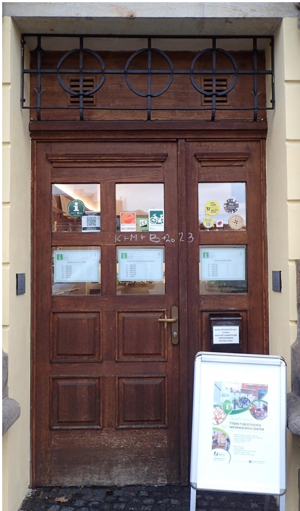
Obr. č. 22 Stav při průzkumu – dveře - 1. NP – vnější strana – celkový pohled Konstrukčně jsou dveře v pořádku, povrchová úprava je dožilá. Barevná lazura se hlavně ve spodní části uvolňuje a odpadá. Pouteč je jednoduše profilovaný.
