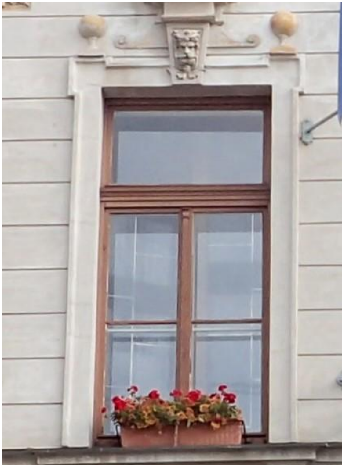
Obr. č. 4 Stav při průzkumu – okno 2. NP – vnější strana – celkový pohled Celkový pohled na okno z náměstí v 2. NP. Konstruktivně je okno v pořádku, povrchová úprava je dožilá. Barevný krycí nátěr se hlavně ve spodní části uvolňuje a odpadá. Stav je podobný jako u oken v 1 np.
