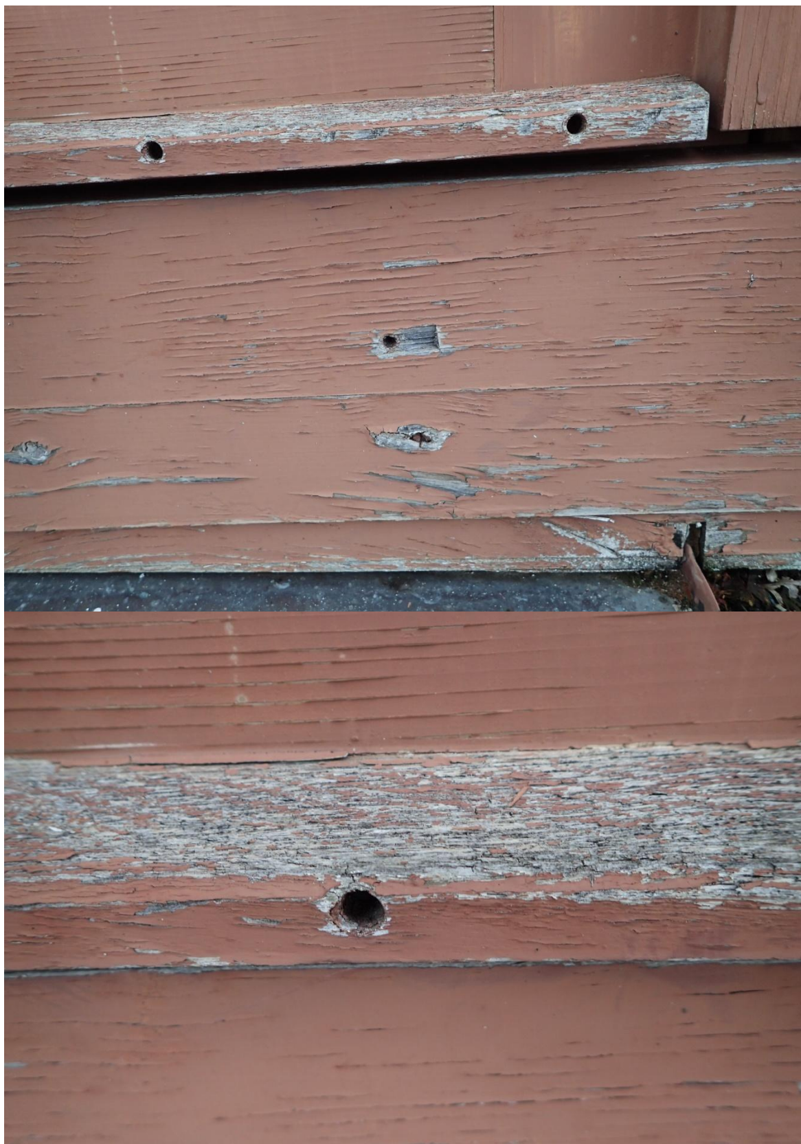
Obr. č. 10+11 Stav při průzkumu – dveře 2. NP – vnější strana – detail – spodní část Povrchová úprava je dožilá. Barevný krycí nátěr se hlavně ve spodní části uvolňuje a odpadá. Ve spojích je barva popraskaná. Dobře patrný je stav okapniček a soklové části dveří, kde jsou vypadané záslepky vrutů.
