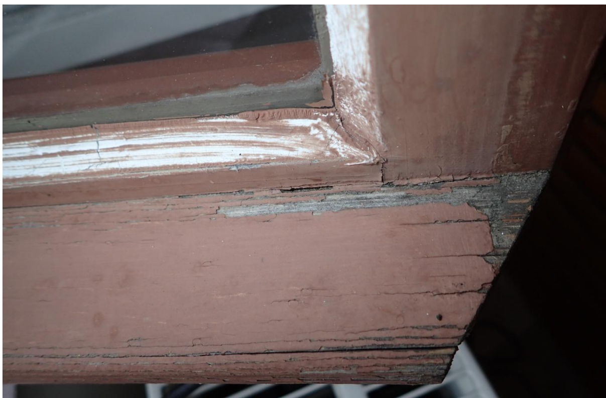
Obr. č. 26+27 Stav při průzkumu – okna /infocentrum/ 1. NP – vnější strana – detail Barevný nátěr je hlavně ve spodní části popraskaný, částečně nesoudržný a na namáhaných místech často chybí. Nesoudržné vrstvy bude nutné odstranit.
