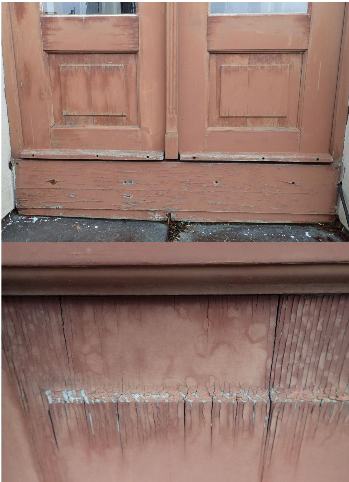
Obr. č. 8+9 Stav při průzkumu – dveře 2. NP – vnější strana – detail – spodní část Konstrukčně jsou dveře v pořádku, povrchová úprava je dožilá. Barevný krycí nátěr se hlavně ve spodní části uvolňuje a odpadá. Ve spojích je barva popraskaná. Dobře patrný je stav výplně a soklové části dveří.
