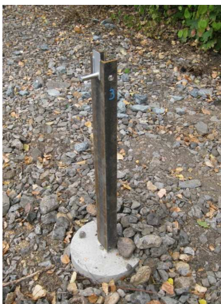
Obrázek 20 Otevřený profil konstrukce sloupku ŽPSV
