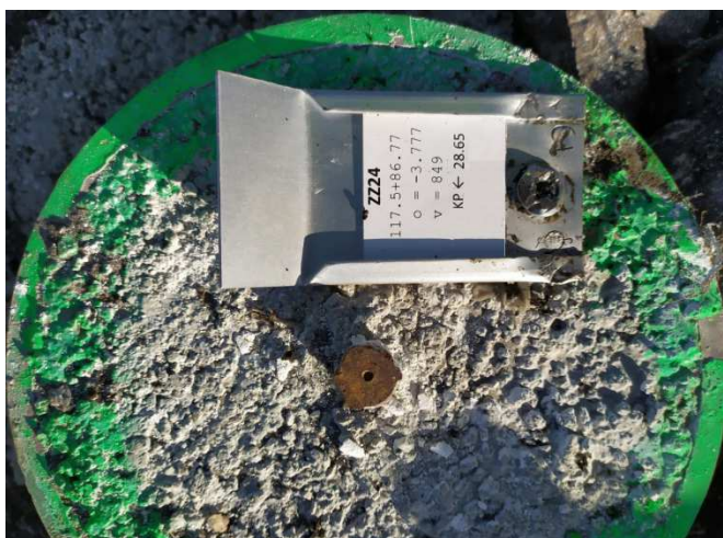
Obrázek 33 Roxor v betonovém bloku (základní odlehčená stabilizace)
