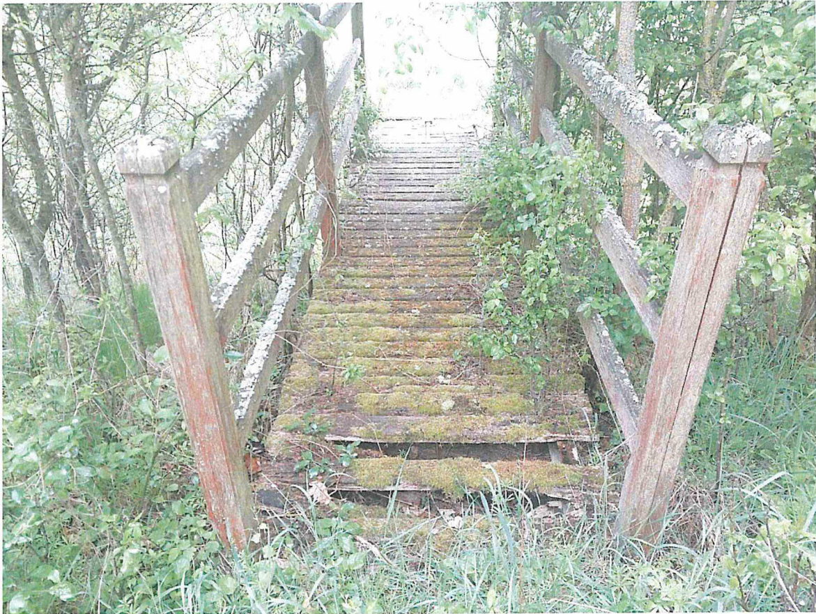
Obr. č. 1: Pohled na lávku nádrže Allah 3
