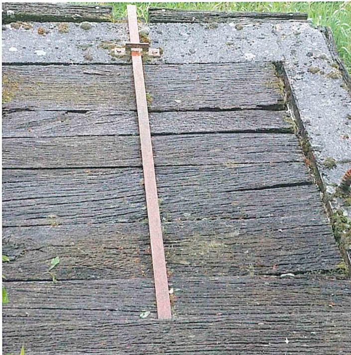
Obr. č. 2: Pohled na poklop tvořený dřevěnými prkny, zajištěný ocelovou petlicí
