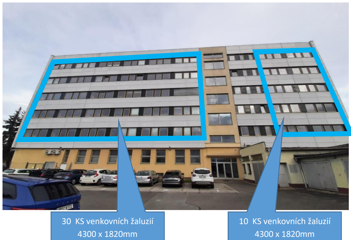
Obrázek 1 Pohled na jižní fasádu budovy KS ČSÚ v Plzni
