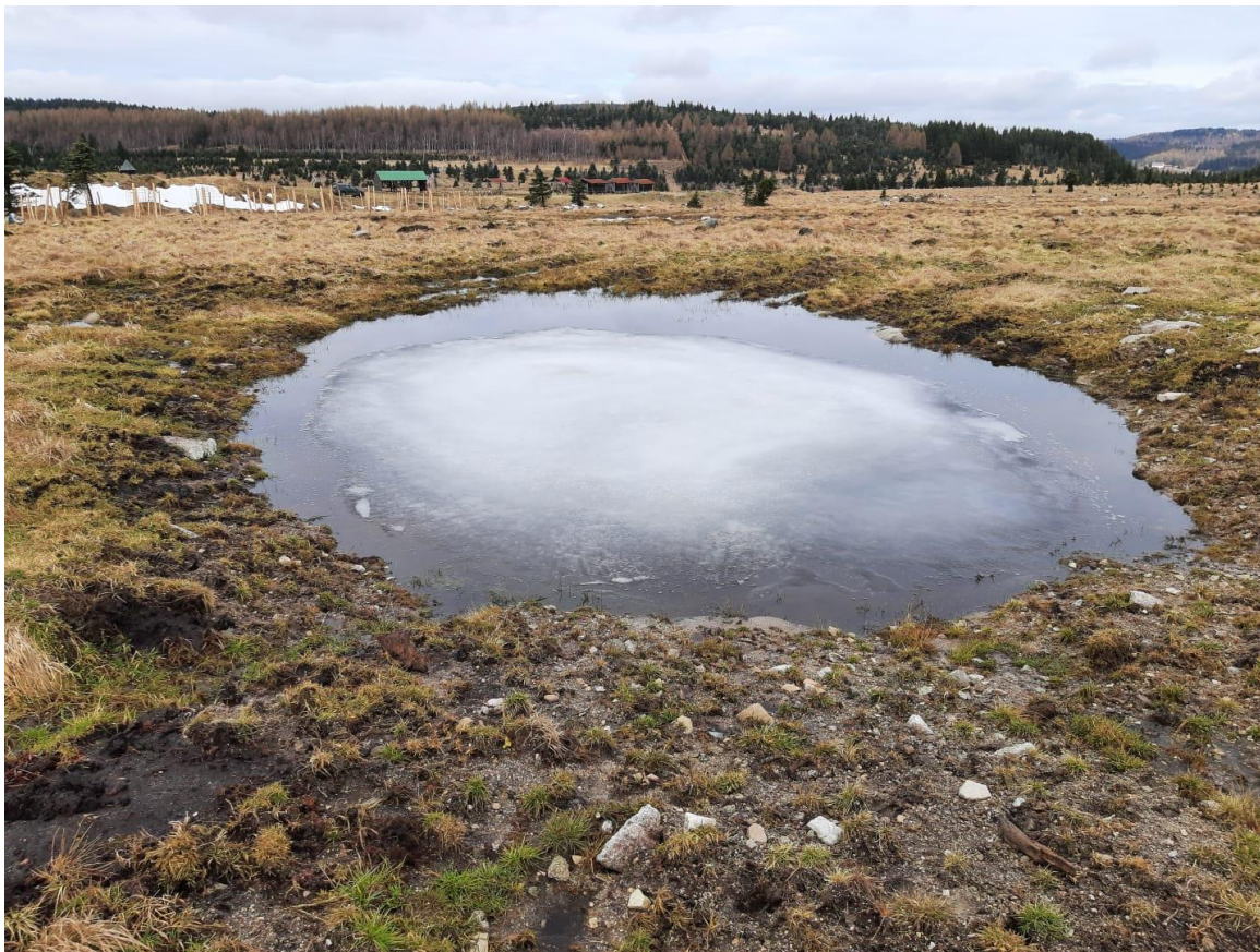
Ukázka realizace vodní zdrže
