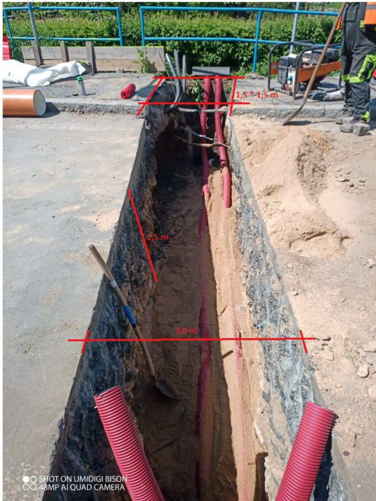
Překopy – provádění překopů komunikace ul. Benešovská
