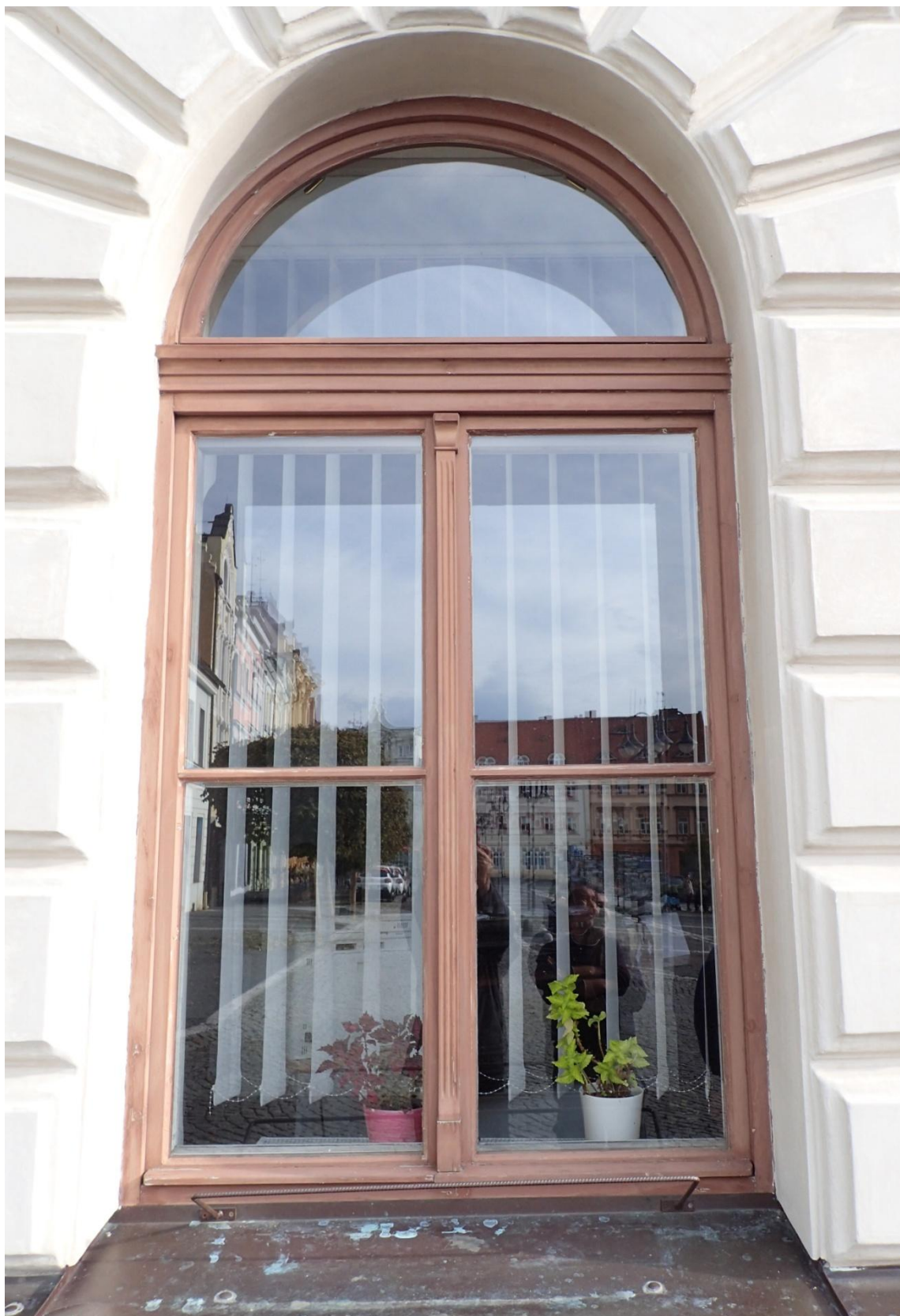
Obr. č. 1 Stav při průzkumu – okno 1. NP – vnější strana – celkový pohled Celkový pohled na okno z náměstí v 1. NP. Konstruktivně je okno v pořádku, povrchová úprava je dožilá. Barevný krycí nátěr se hlavně ve spodní části uvolňuje a odpadá /viz detaily/.
