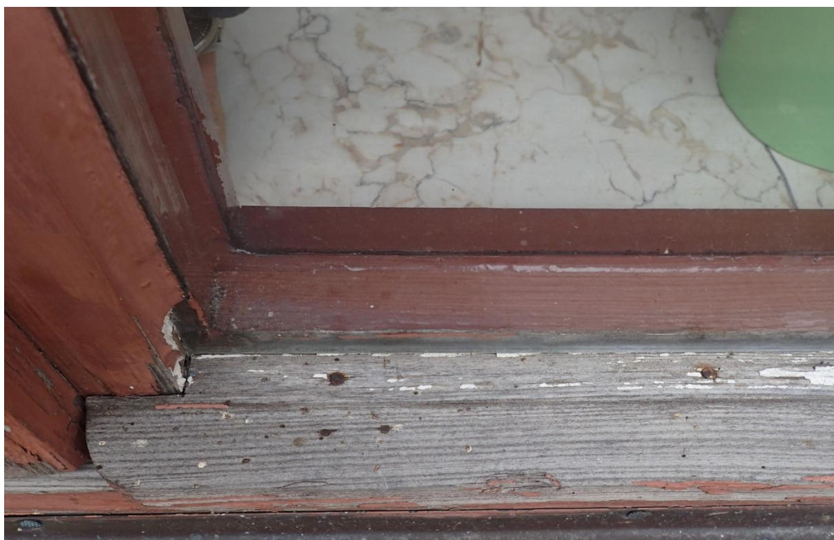
Obr. č. 28+29 Stav při průzkumu – okna /infocentrum/ 1. NP – vnější strana – detail Barevný nátěr je hlavně ve spodní části popraskaný, částečně nesoudržný a na namáhaných místech často chybí. Nesoudržné vrstvy bude nutné odstranit. Lokálně jsou uvolněné sklenářské tmely, které bude nutné při opravě doplnit.
