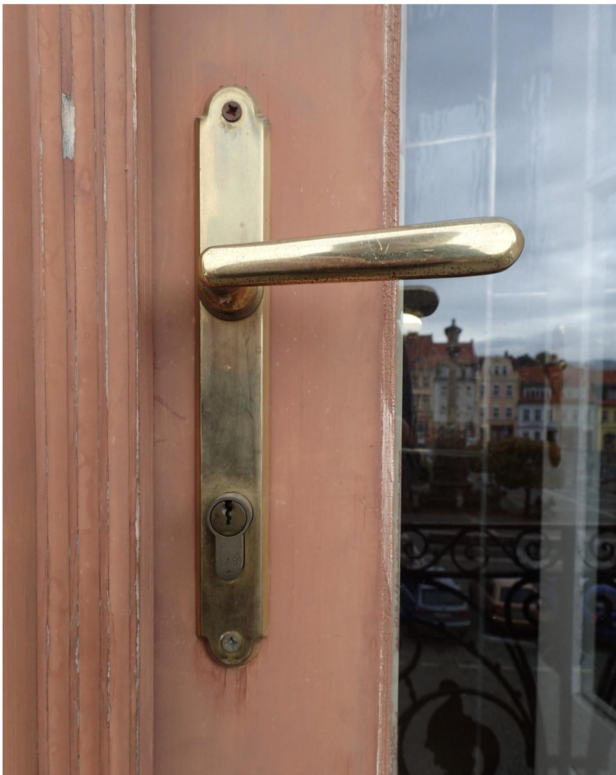
Obr. č. 12 Stav při průzkumu – dveře 2. NP – vnější strana – detail – kování Povrchová úprava je dožilá. Na dveřích stejně jako na oknech je použito kování ALT WIEN v lesklém provedení.
