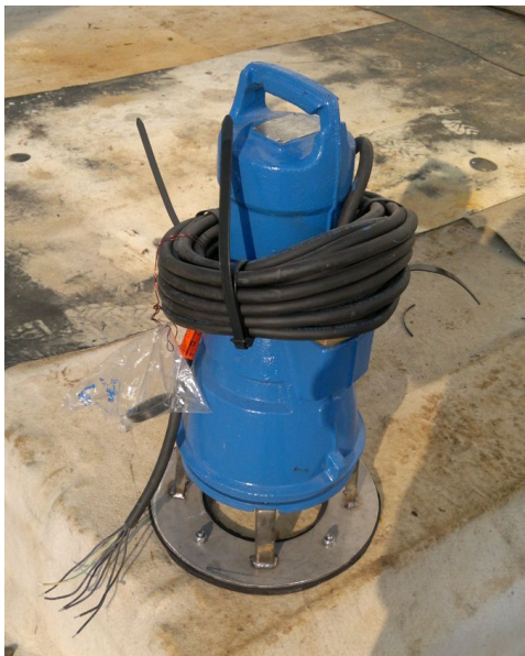
Obr. 4.4 Střešní čerpadlo po opravě včetně nového podstavce
