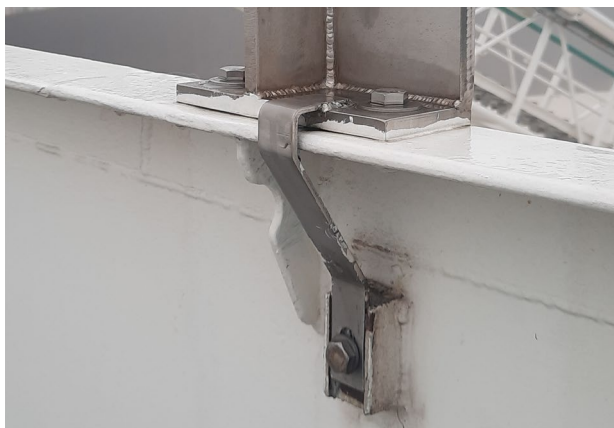
Obr. 3.1 Instalace zemnicího bodu a výztužného žebra
