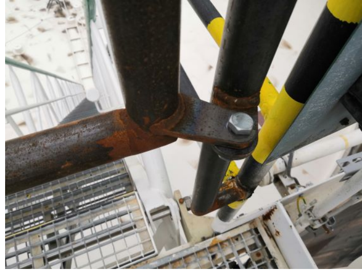
Obr. 3.10 Detail montáže pantů
