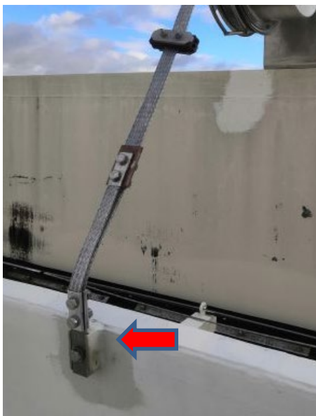
Obr. 4.6 Umístění zemnicího bodu na pěnové hradítko
