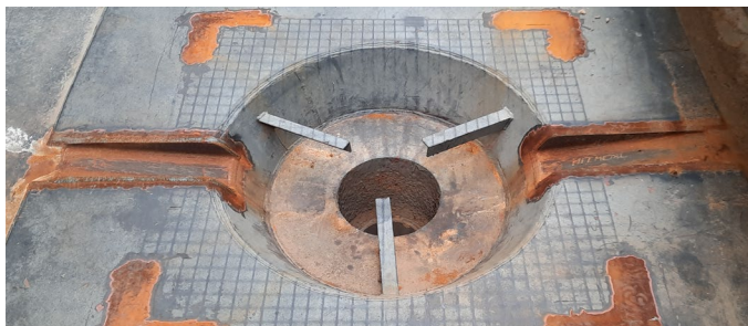
Obr. 3.7 Stav po provedené úpravě
