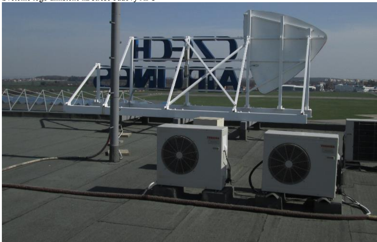
Světelné logo umístěné na střeše budovy APC
