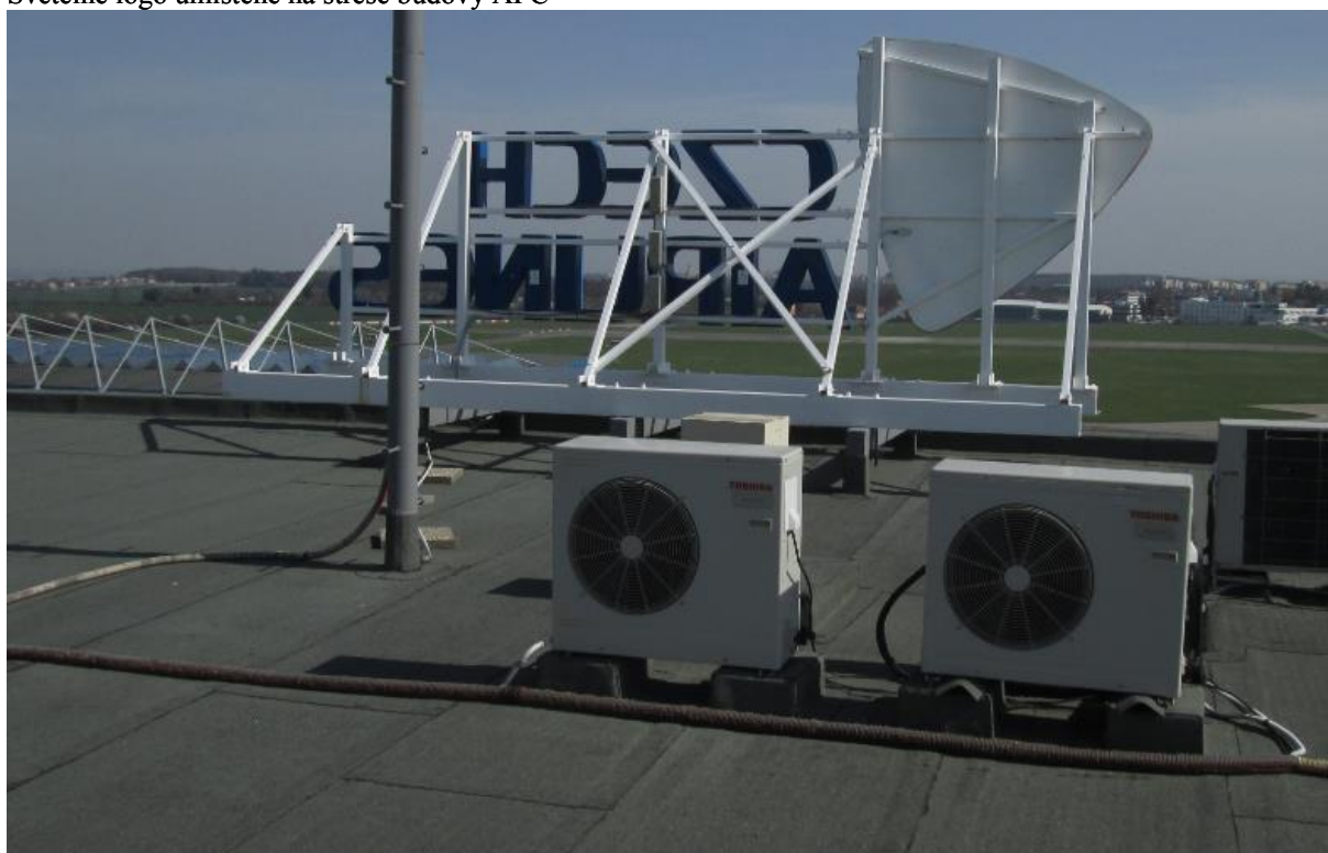
Světelné logo umístěné na střeše budovy APC
