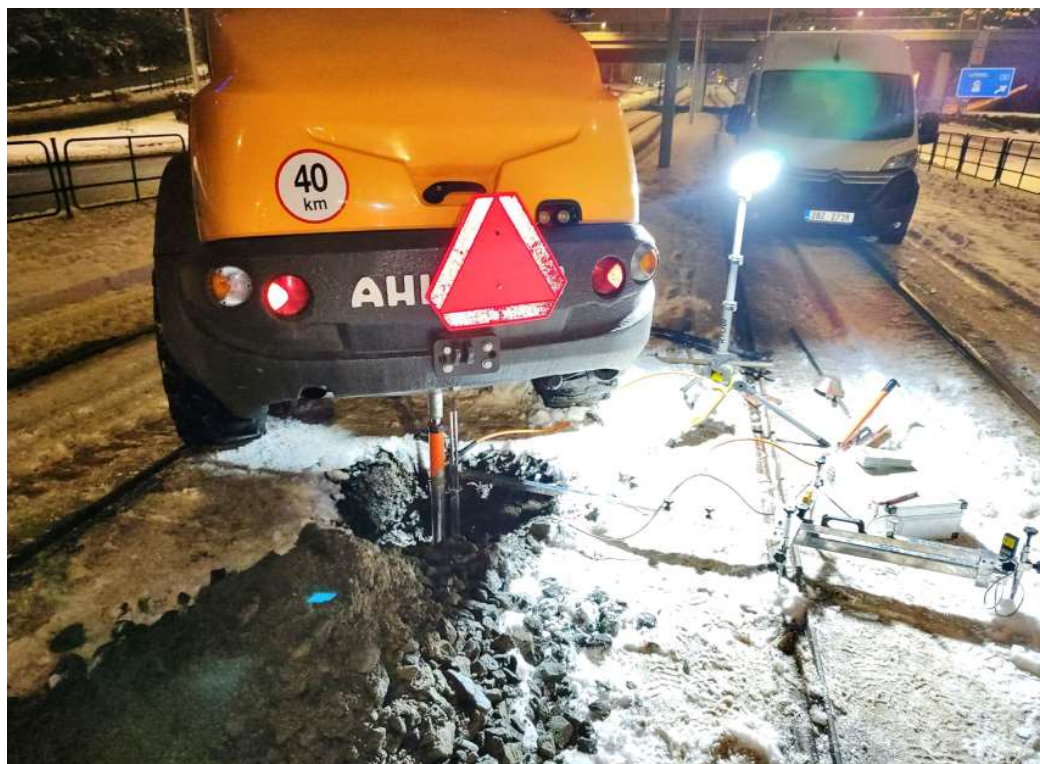
Obrázek 8: Provádění STZZ v místě KS2
