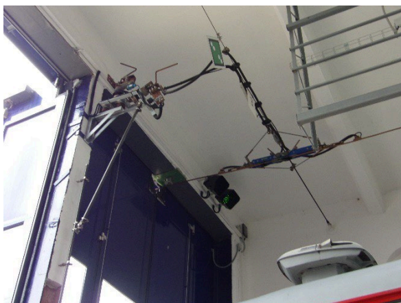
Obr. 36: Odpojovač I
