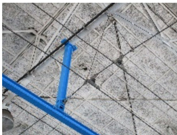
Obr. 26: Trakční vedení na nosné konstrukci budovy
