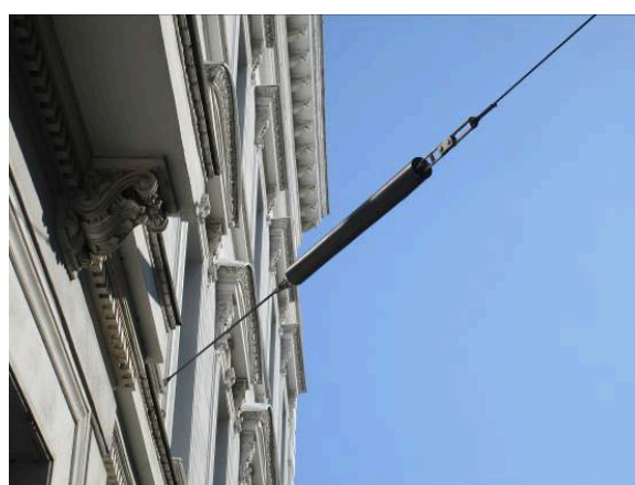
Obr. 8: Pružinový napínač
