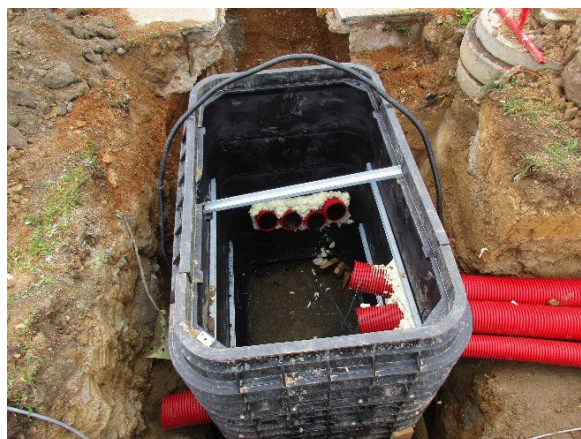
Obr. 47: Ochranná trubka v kabelové komoře
