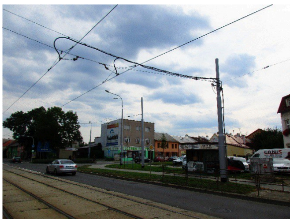
Obr. 29: Napájecí bod
