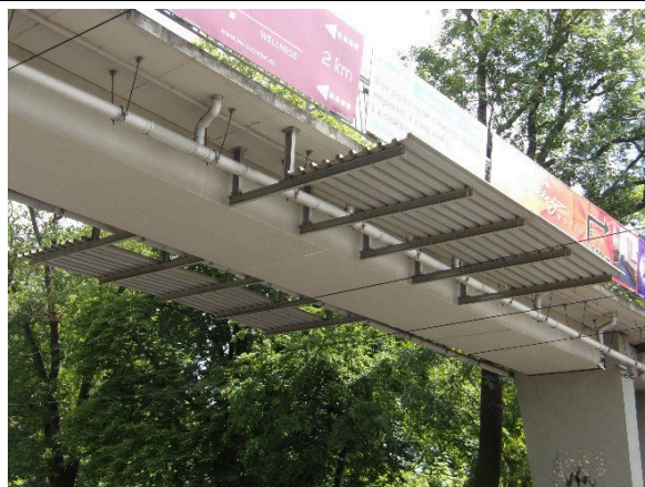
Obr. 12: Protidotykové zábrany upevněné na konstrukci mostu
