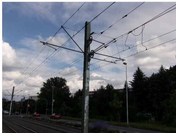
Obr. 6: Pohyblivé kotvení řetězového vedení západkovým kladkostrojem v poměru 1:3
