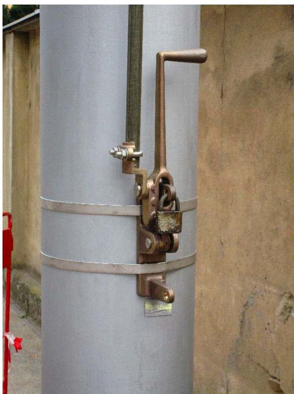
Obr. 38: Ruční pohon odpojovače
