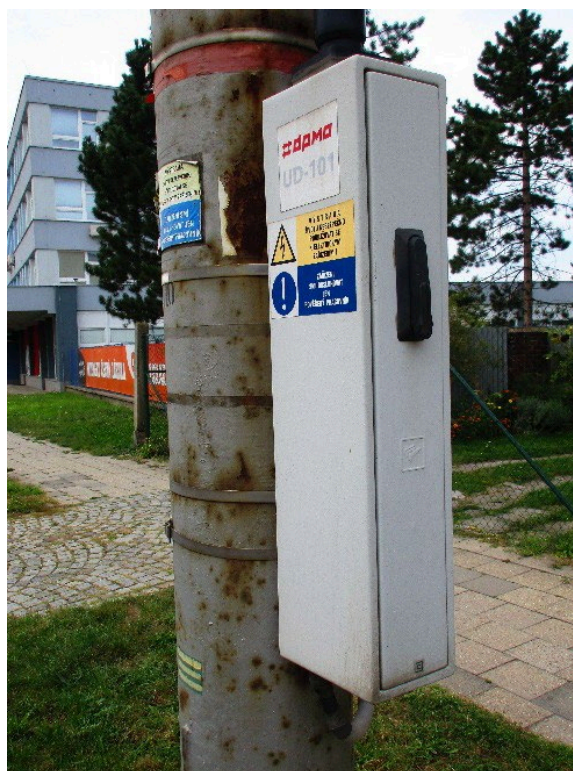
Obr. 39: Motorový pohon odpojovače
