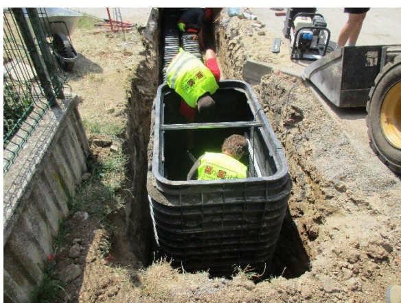
Obr. 48: Kabelová komora
