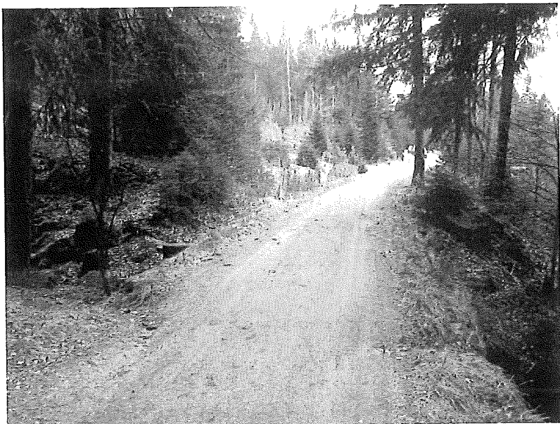
Celkový pohled na most z pravobřežního předpolí
