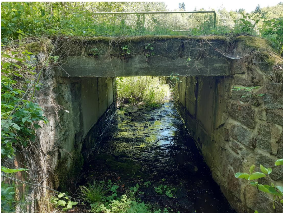
Obr. 2 - Odpadní koryto od bezpečnostního přelivu
