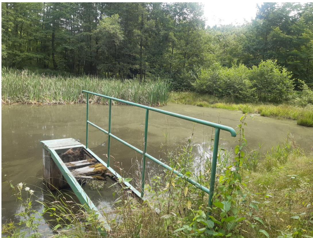
Obr. 2 - Stávající požerák s lávkou
