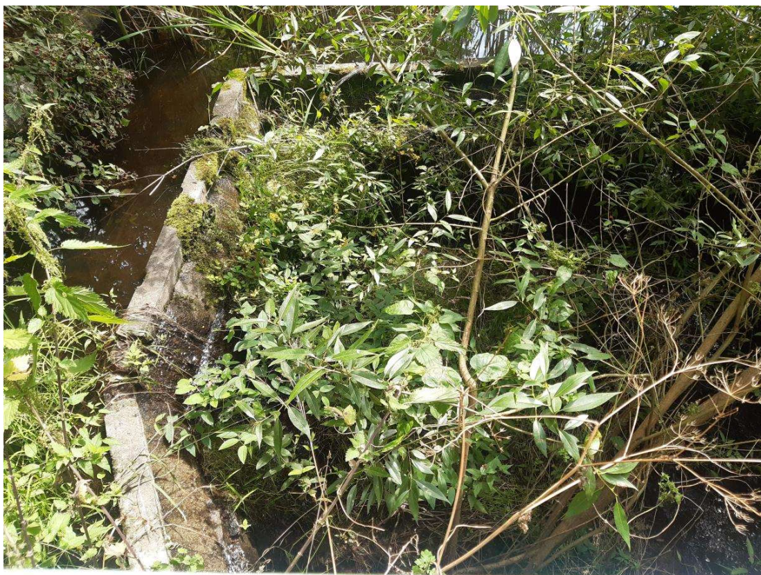
Obr. 1 - Stávající bezpečnostní přeliv
