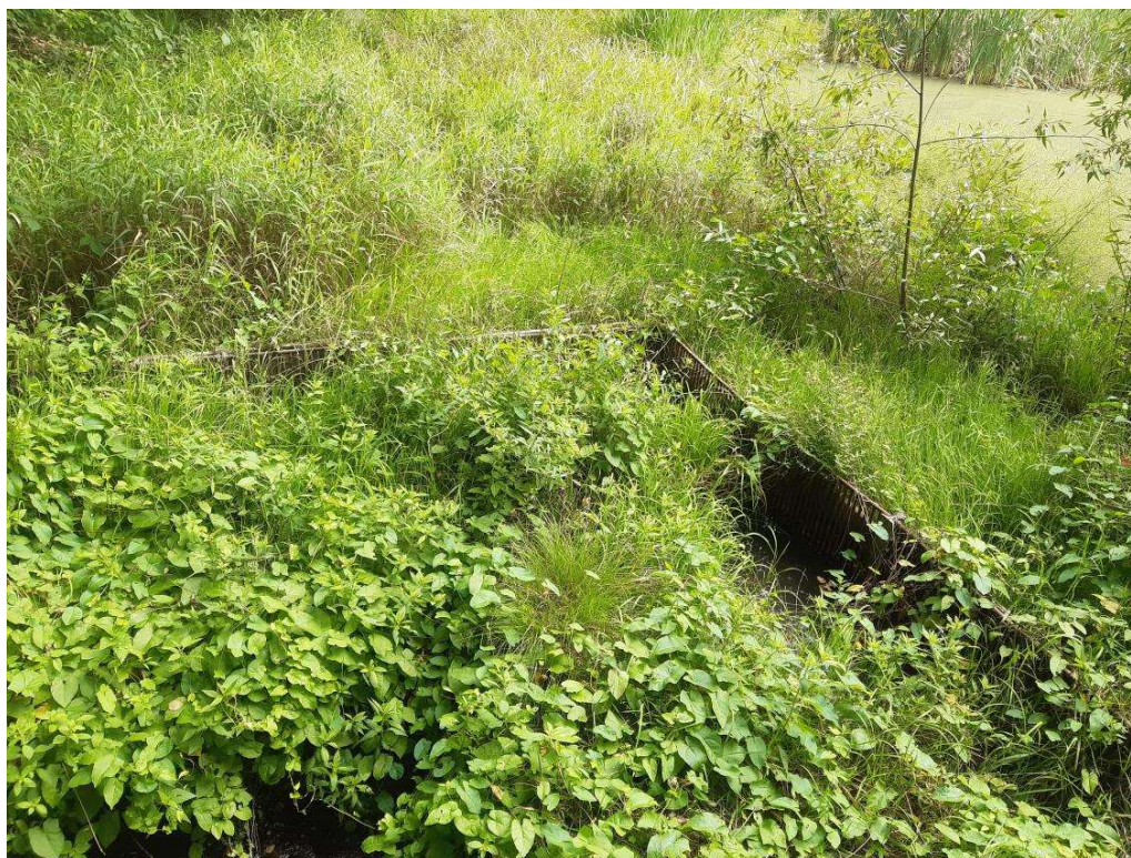
Obr. 1 - Stávající bezpečnostní přeliv
