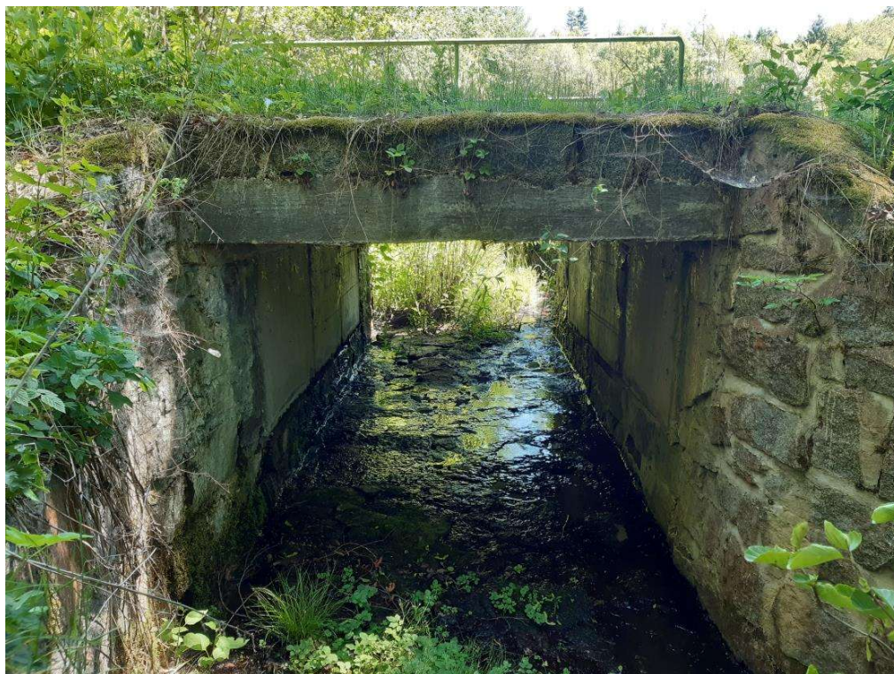
Obr. 2 - Odpadní koryto od bezpečnostního přelivu
