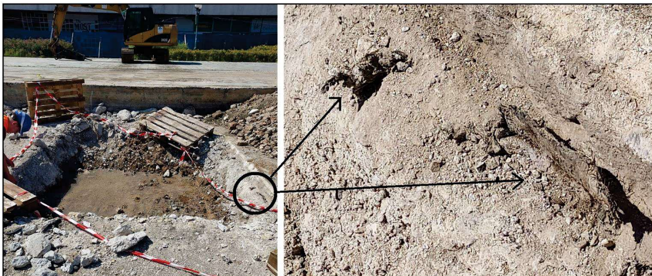
Obr. č. 3 Sonda do okrasného venkovního bazénu, detail místa odběru VZORKU č. 1
