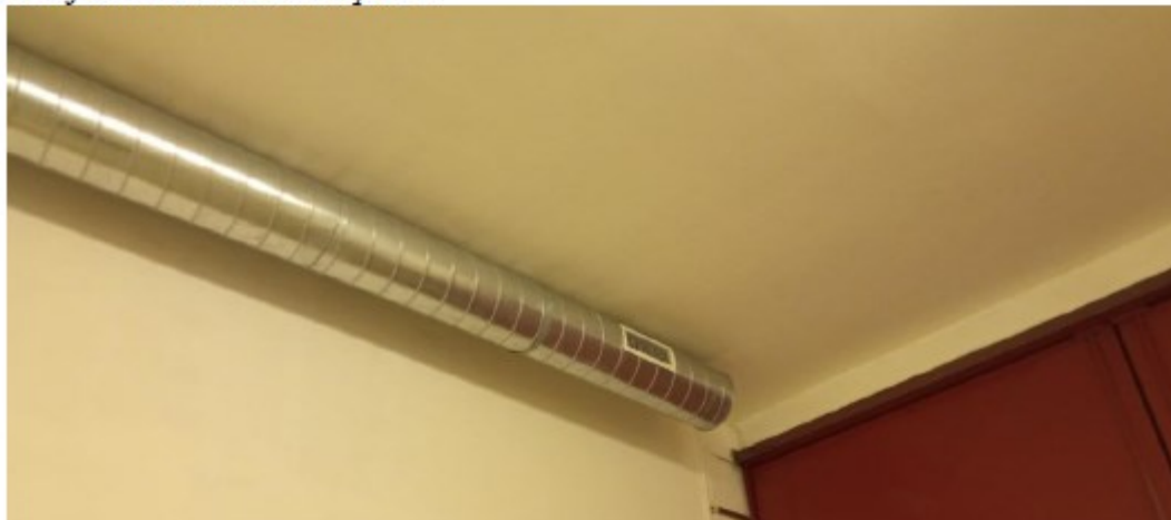
Stávající vedení VZT a SDK pohled
