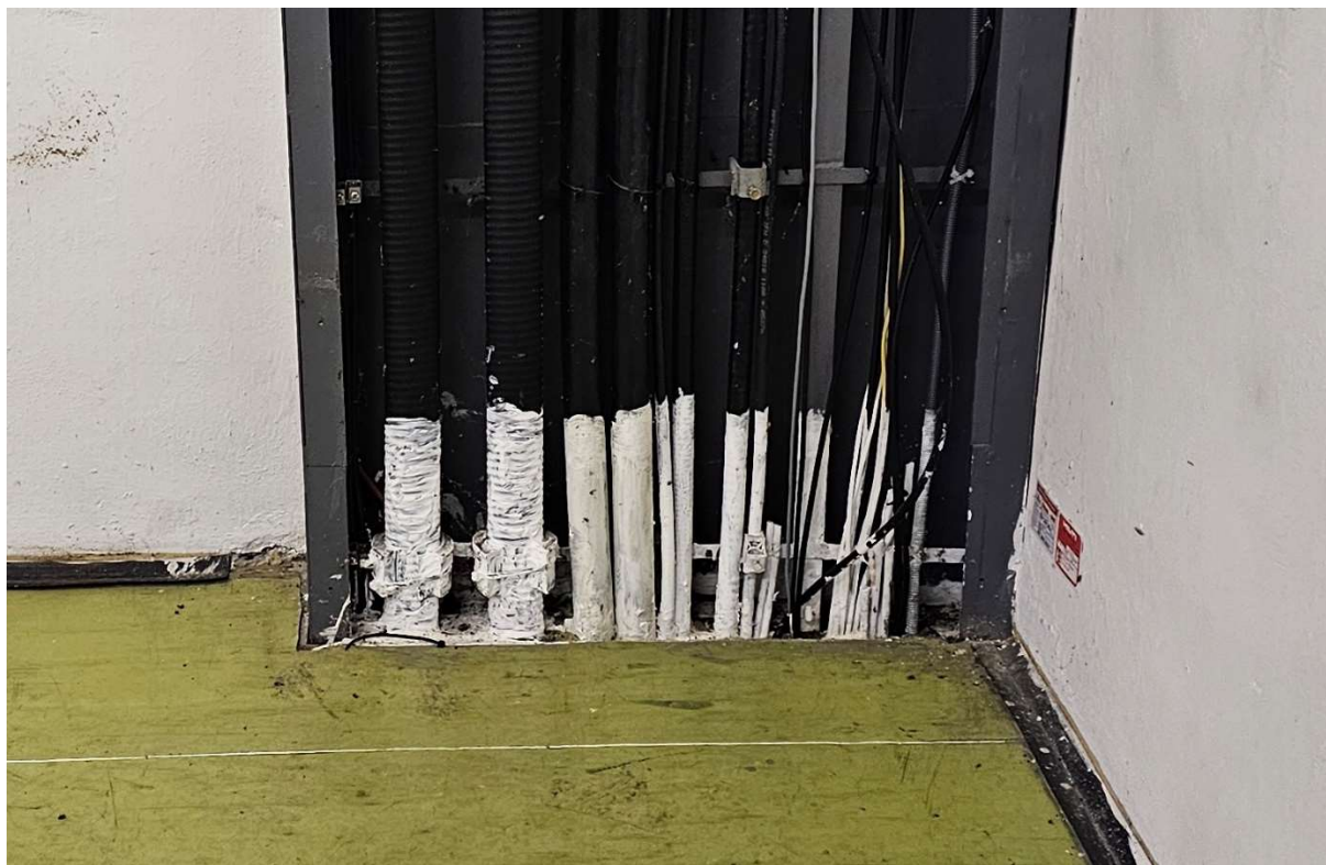
Obrázek 6 Prostup pro optický kabel mezi patry
