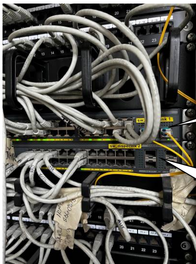
Obr. Aktivní prvky v datovém racku
