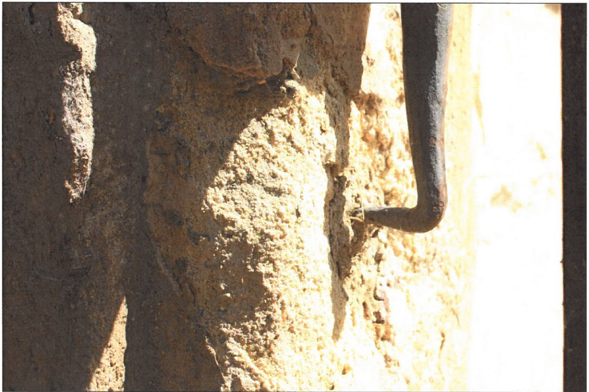
Hlubková degradace hmoty pískovce u osazení pantu.
