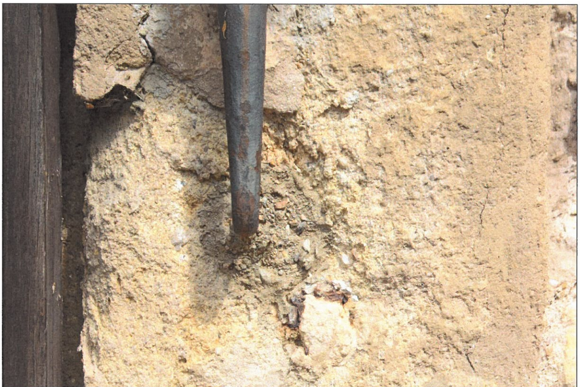
Osazení pantu do ostění na cementový tmel.
