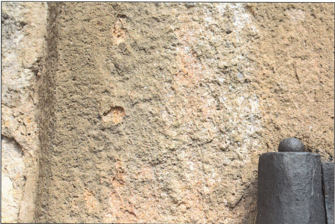
Povrchová degradace pískovce práškovatěním, lokální krystalizace vodorozpuštných solí.
