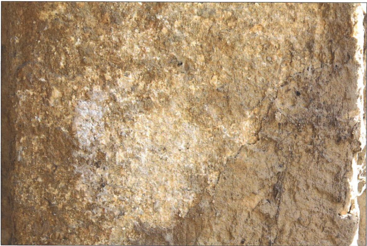
Povrchová degradace pískovce práškovatěním, lokální krystalizace vodorozpuštných solí.
