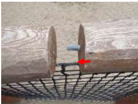
9) Do prostoru vyčnívá ostrá závitová tyč, která spojovala zábradlí lodi
