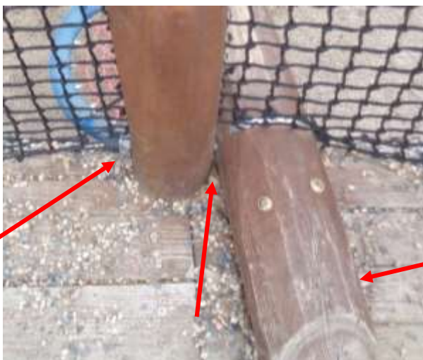
10) Závitová tyč, která prochází břevnem závěsné houpačky a stojiny je uvolněna, přesahující kulatinu břevna lze navíc považovat za překážku v prostoru .
