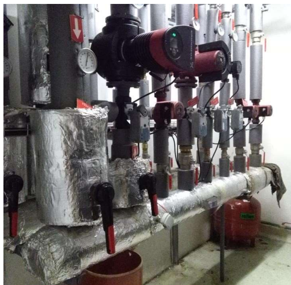
Obr. č. 6 – Rozdělovač a sběrač ÚT
