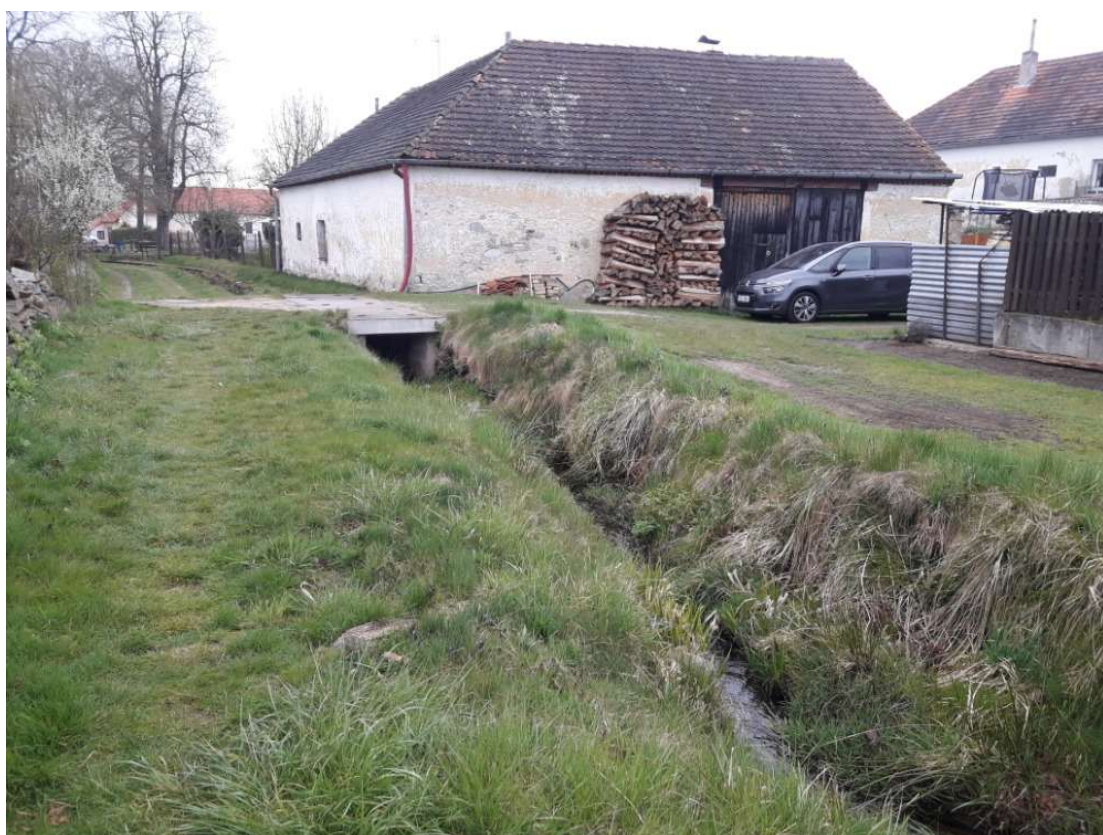
Horní část úpravy (SO 03) – kamenná rovnanina a přemostění toku
