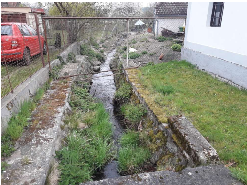
Spodní úsek pod hasičskou zbrojnicí (pohled po vodě – SO 01) – obnova zdí a přechod do kamenné rovnániny
