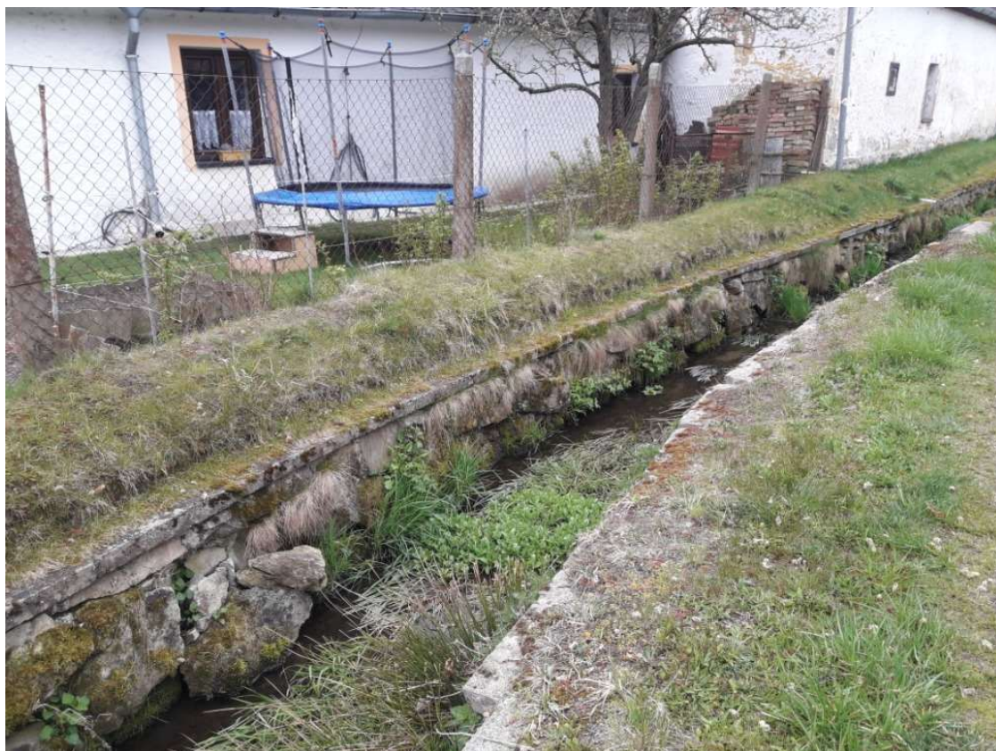
Úsek v zastavěné části obce (SO 02) – obnova oboustranných zdí
