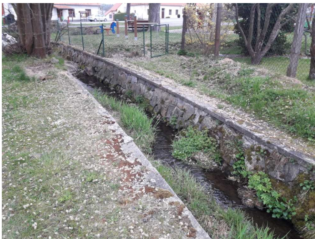
Úsek podél dětského hřiště na návsi nad silničním propustkem (SO 02) – obnova zdí
