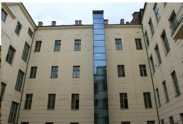
Dvorní fasáda – původní okna
