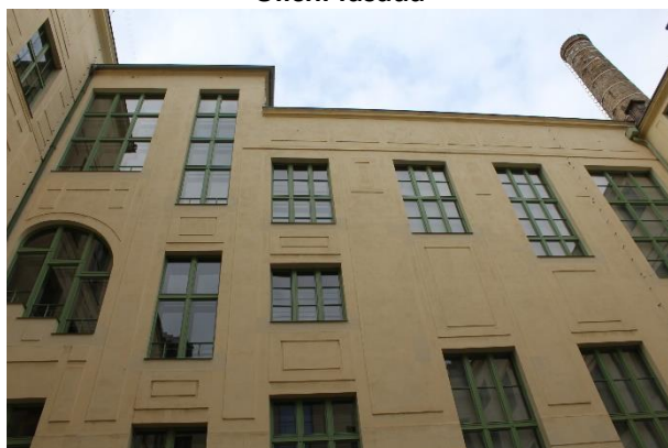
Dvorní fasáda – nová okna
