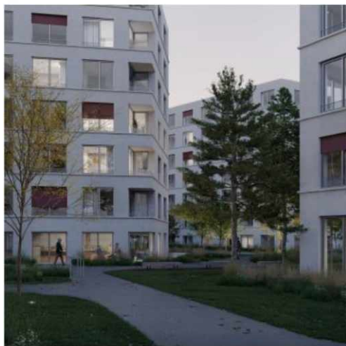
Bytový dům 4 Dvory České Budějovice
