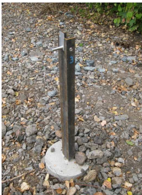
Obrázek 20 Otevřený profil konstrukce sloupku ŽPSV
