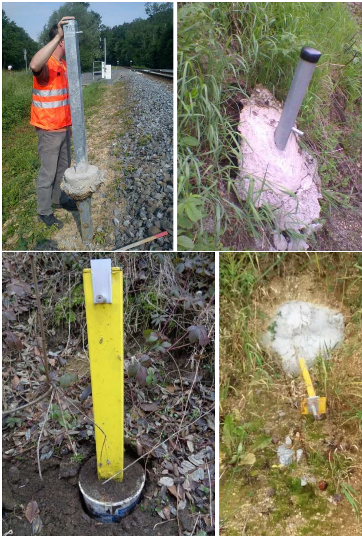
Obrázek 18 Ukázka neschválených, nestabilních a vyloženě nevhodných zajištění PPK
