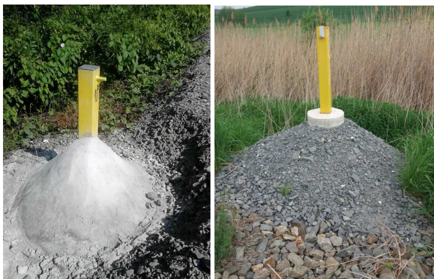
Obrázek 17 Řešení zhotovitele pro zvýšení stability zajišťovací značky
