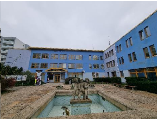
Obrázek 6: Pohled IV - budova č. 638
