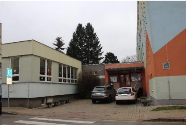
Obrázek 27: Pohled na spojovací krček mezi starou a novou budovou
