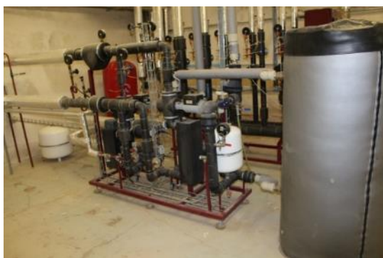
Obrázek 19: Výměníková stanice
