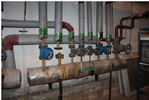
Obrázek 66: Rozdělovač
