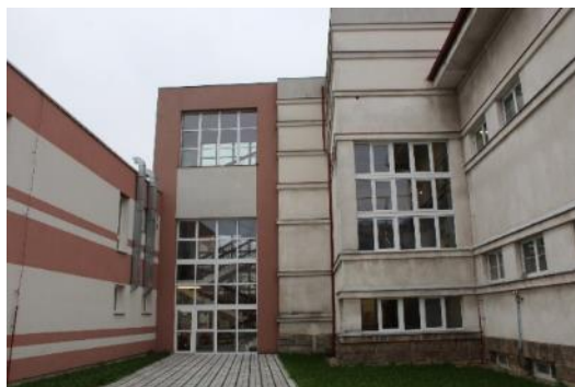
Obrázek 16: Pohled propojení staré a nové budovy
