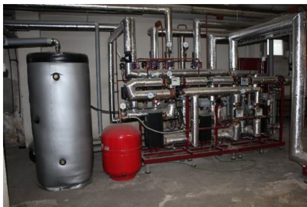
Obrázek 28: Výměníková stanice
