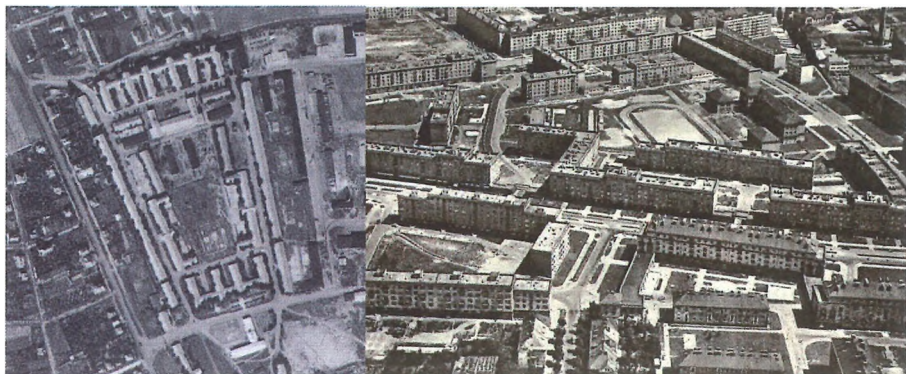
Letecký snímek původních kasáren
