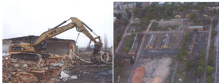
Demolice kasáren v roce 2008
