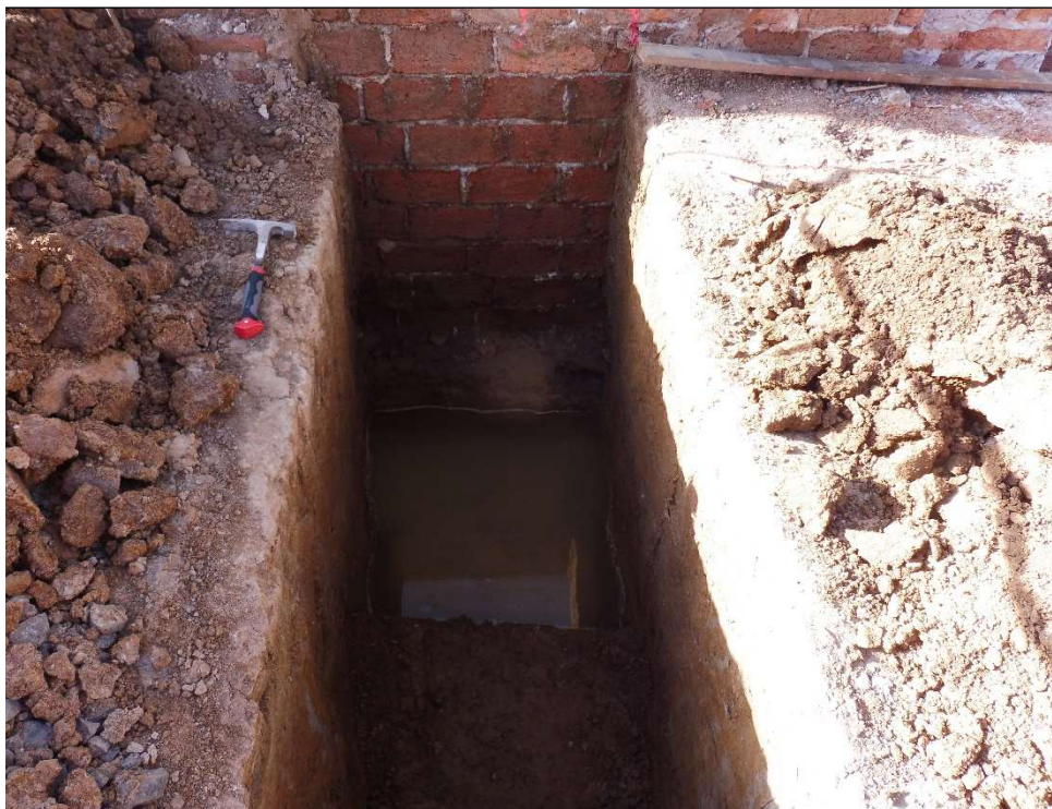
Obr. 2: Pohled na základovou spáru pod základovým pasem ZP1.
