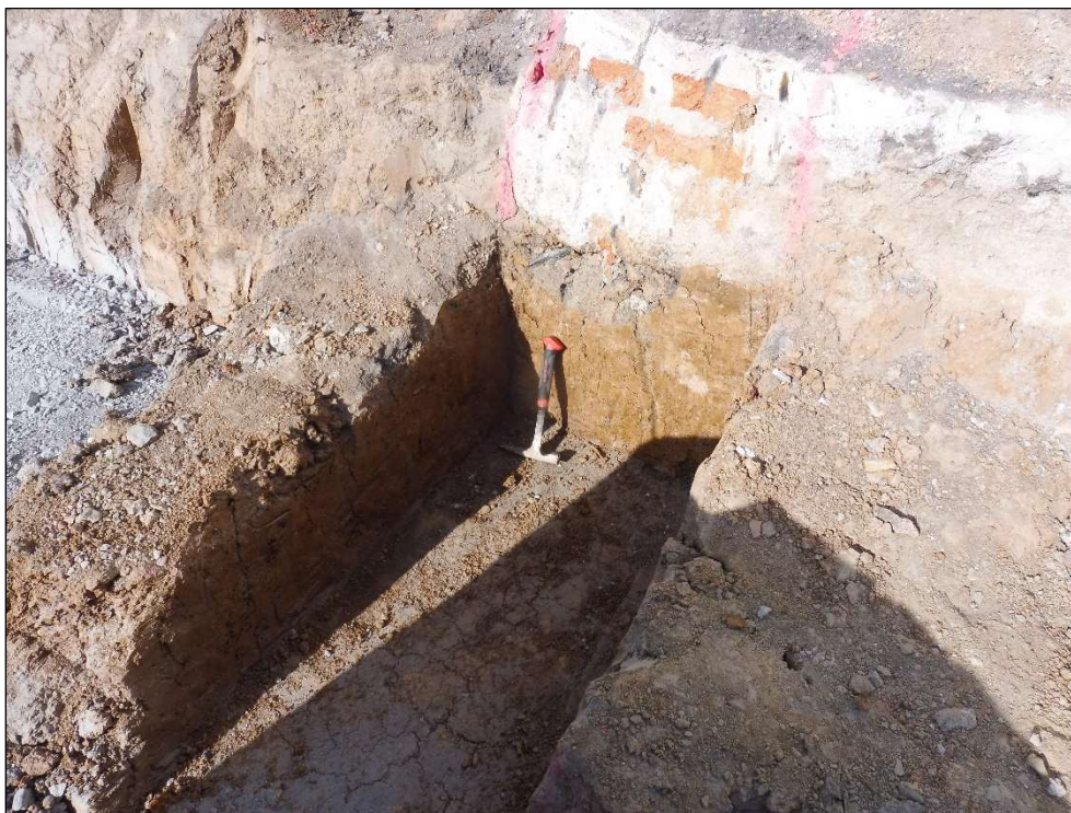
Obr. 3: Pohled na základovou spáru pod základovým pasem ZP4.
