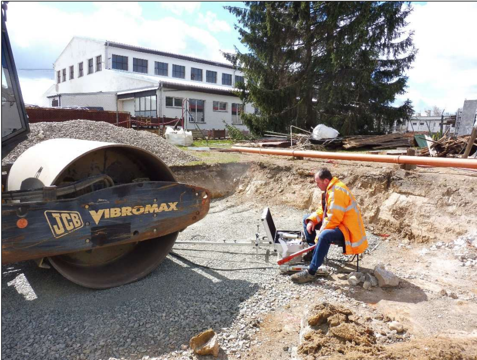
Obr. 1: Kontrola míry zhutnění zemní pláně na zkušebním poli
