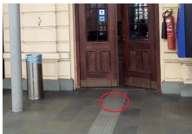
Poškození dlažby
