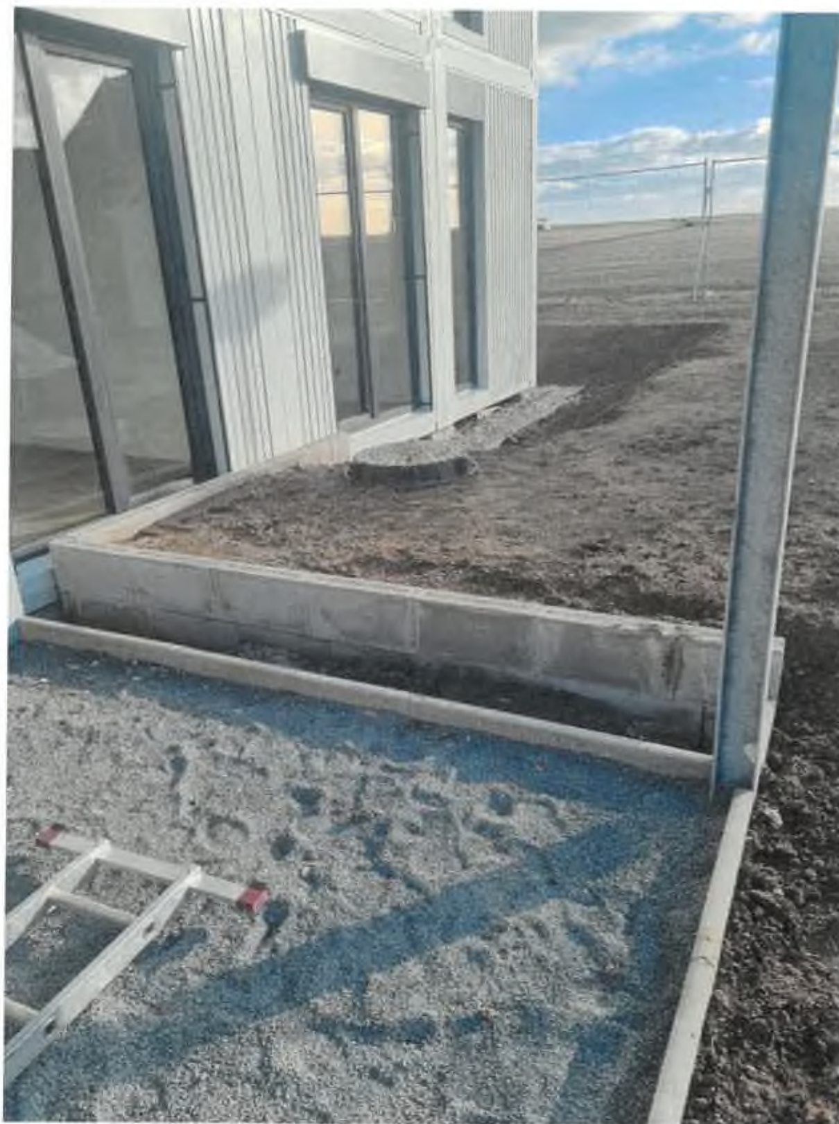
01 – Stěna z tvárnic ze ztraceného bednění
