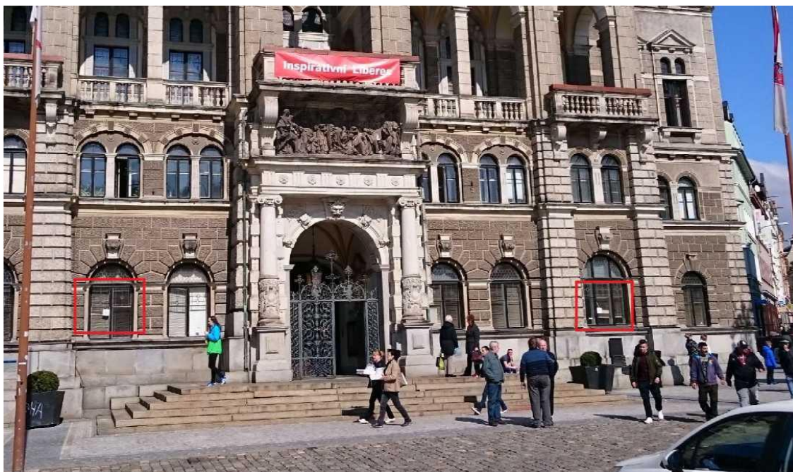
Obrázek č. 2 – umístění zkušebních AP Cisco řady 1131 v přízemních oknech historické Radnice
